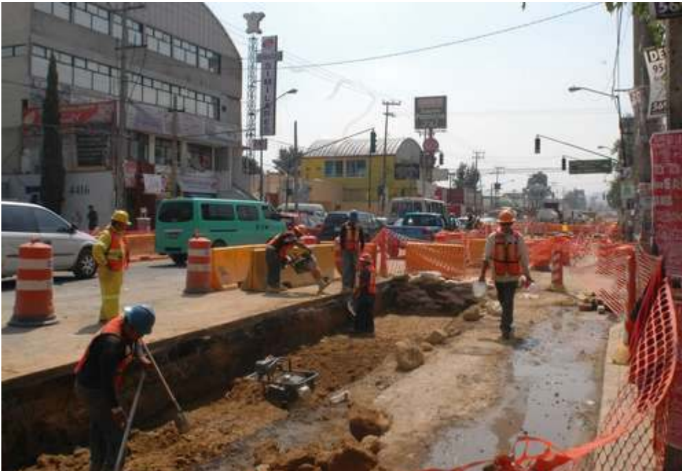
Obras del Sistema de Transporte en la Av. Tláhuac
