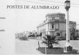
POSTE DE ALUMBRADO HIPÓDROMO Y AV. AMSTERDAM
