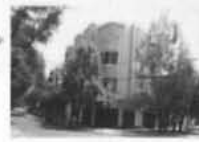
EDIFICIO AMSTERDAM Av. Amsterdam 154 erg. Ordama
