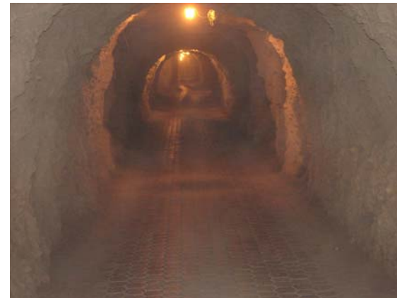
Vista interior del túnel Ogarrío
