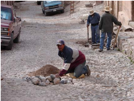
Calles en reparación debido a su deterioro
