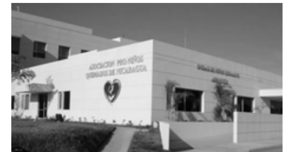
Fig. IV-57. Perspectiva de la Unidad de Quemados, vista desde su fachada principal.
