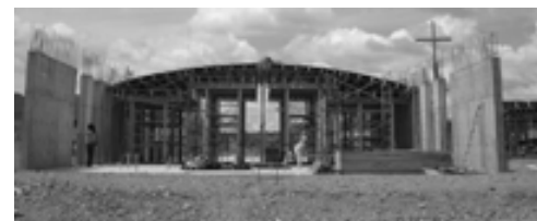
Fig. IV-44. El Hospital en construcción.
