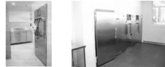
Fig. II-17 y 18. Central de equipos y esterilización. Los equipos de esterilización de vapor autogenerado por calor seco y húmedo aseguran la eliminación de contaminantes que puede presentar el instrumental utilizado.
