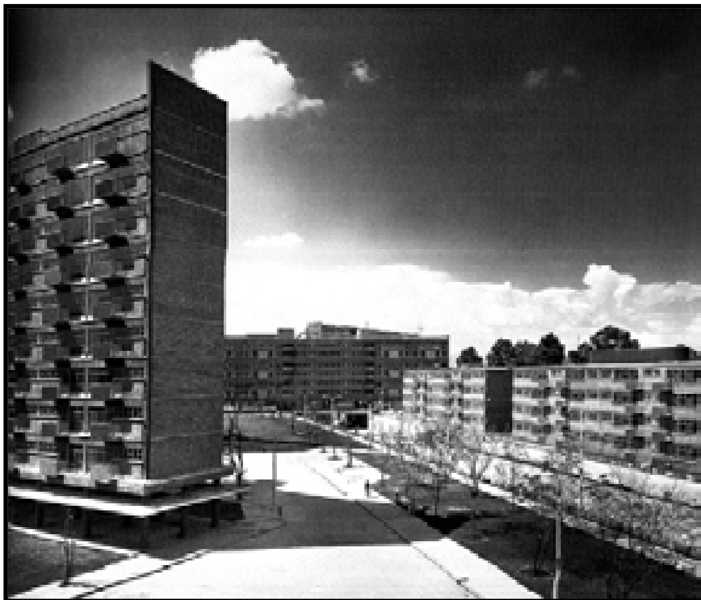
Circulación de la Avenida Orizaba por debajo del conjunto.
