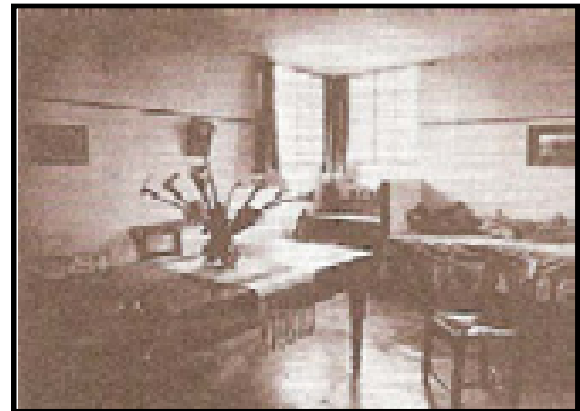
Prototipo de vivienda construida y amueblada en la Colonia Moctezuma, previo a la realización de los conjuntos habitacionales, Arq. Juan Legarreta 1932.
