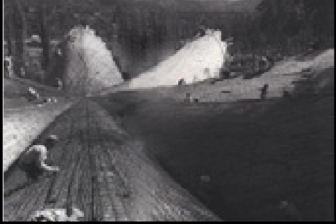
Armado de varilla del restaurante Los Manantiales en Xochimilco, 1957.
