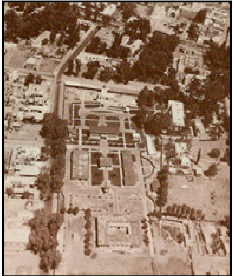
Vista aérea del conjunto
