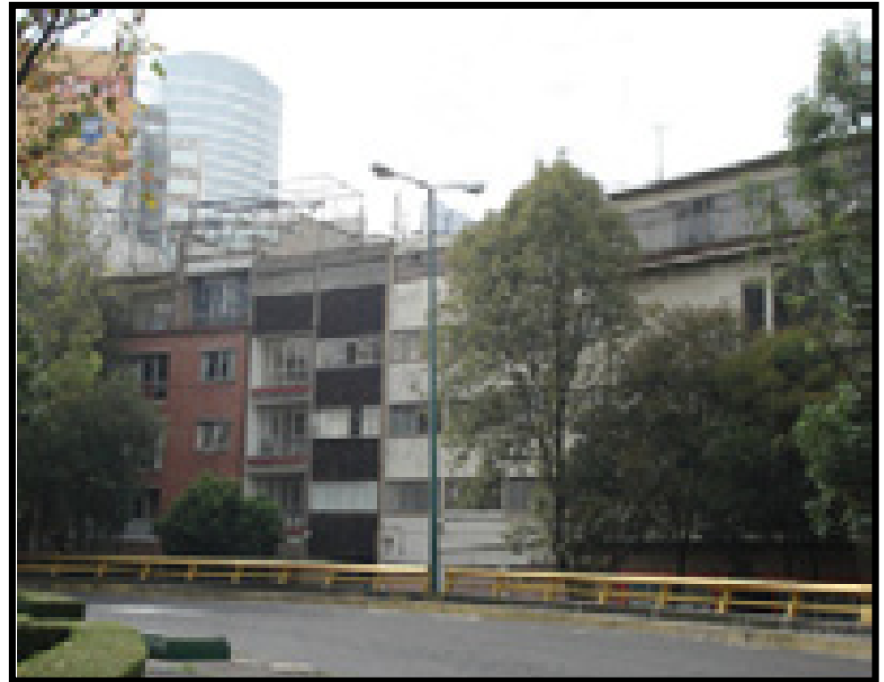
Conjunto de edificios departamentales en la glorieta Melchor Ocampo, (de izq. a der.) Arqs. Juan Sordo Madaleno y Augusto H. Alvarez; Luis Barragán y Max Cetto; Luis Barragán y José Creixell; 1939-1945.
