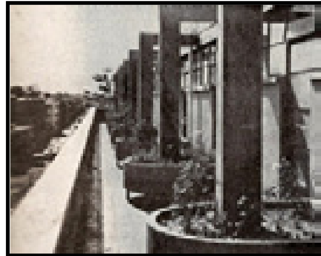
Terraza jardín en el Edificio del Sindicato Mexicano de Electricistas.
