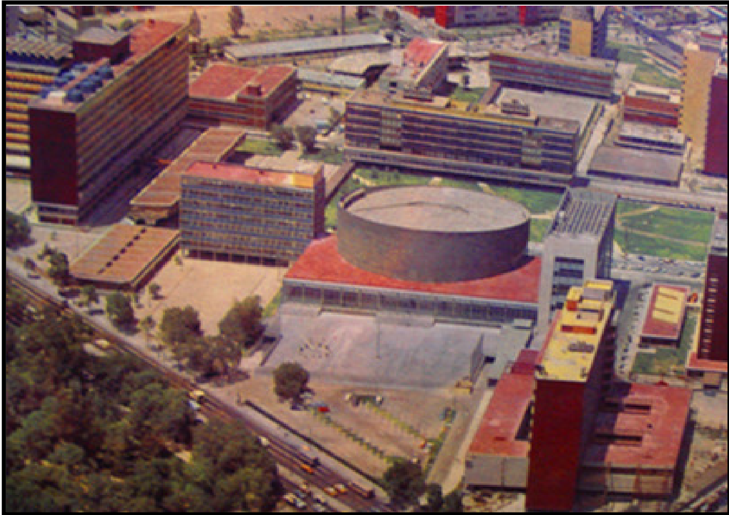
Vista General del Conjunto.
