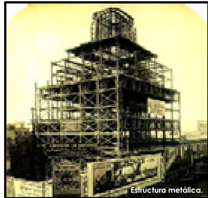
Edificio de La Nacional, Arq. Manuel Ortiz Monasterio, 1930.
