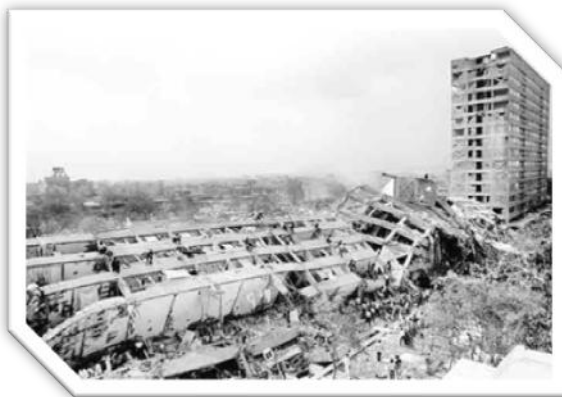
Ruinas del edificio Nuevo León (1985) Foto/ Archivo La Jornada
