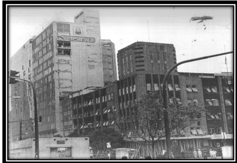
Daños que sufrió el antiguo edificio de pensiones del ISSSTE, a causa de los sismos del 19 y 20 de septiembre de 1985. Fotografías/ Archivo ISSSTE
