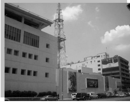
Ubicación: Av. Chapultepec No. 18, colonia Doctores, Delegación Cuauhtémoc. Estado: Inmueble reconstruido
