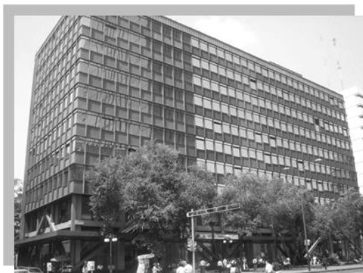
Ubicación: Humbolt 26, esquina Av. Juárez, colonia centro, Delegación Cuauhtémoc. Estado: Inmueble reforzado con amortiguadores antisísmicos.
