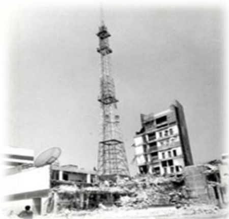
Instalaciones de Televisa Chapultepec, después del terremoto Foto/Archivo Proceso
