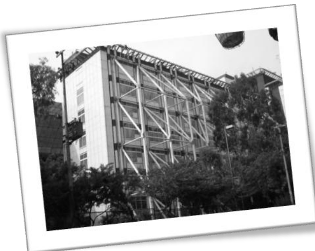
Ante la eventual presencia de un intenso movimiento telúrico en la Ciudad de México, la construcción que alberga al Centro Médico Nacional 20 de Noviembre, cuenta con amortiguadores sísmicos que mantienen al inmueble en posición vertical. Foto/Liliana Sánchez Bermúdez
