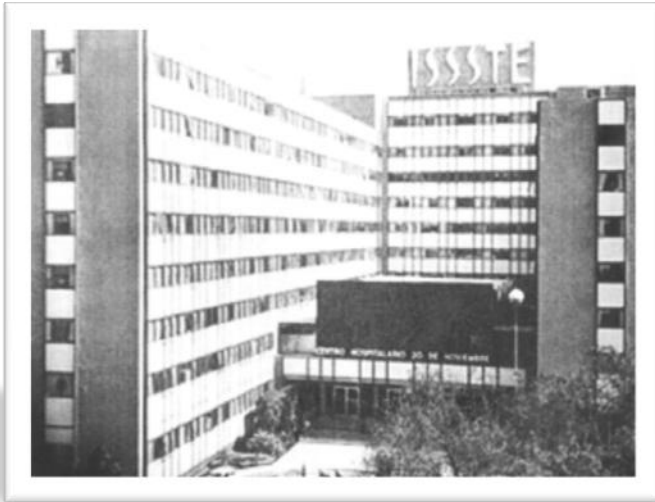
En 1961 se inauguró el Hospital 20 de Noviembre. Foto/ Archivo ISSSTE
