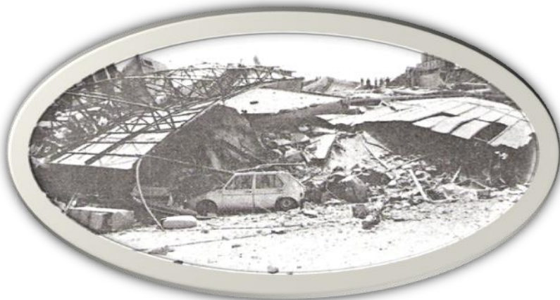
Grandes estructuras no soportaron el terremoto y se colapsaron. Foto/ Archivo Proceso
