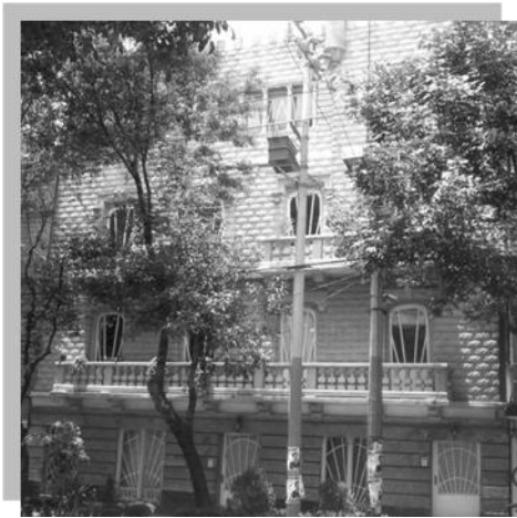
Ubicación: Querétaro No. 72, colonia Roma, Delegación Cuauhtémoc. Estado: Inmueble reestructurado.
