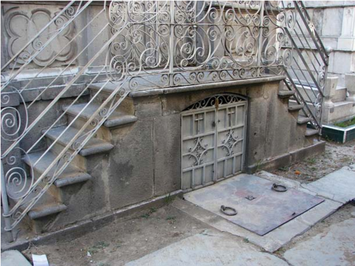
Figura 17. Puerta de acceso a la cripta. Foto: Zurisadai A. Guarneros y Francisco A. Razo
