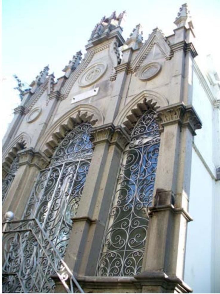
Figura 15. Fachada principal de la cripta. Foto: Gerardo Valenzuela J.
