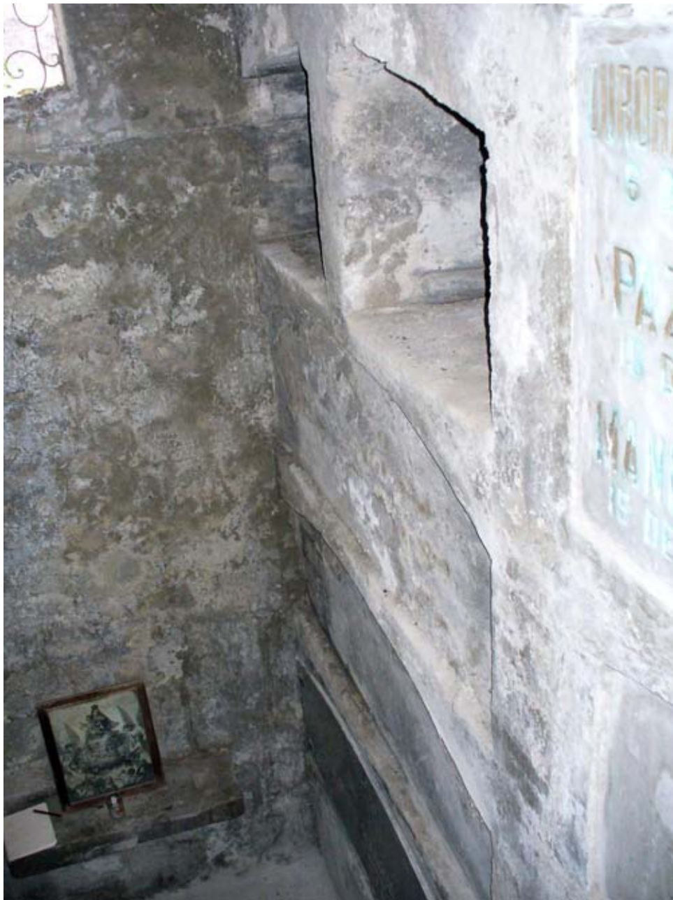
Figura 22. Vista parcial de la pared izquierda en la primer visita. Foto: Gerardo Valenzuela J.
