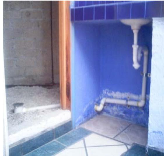
Figura 2.3 Separación de agua gris en lavabos
