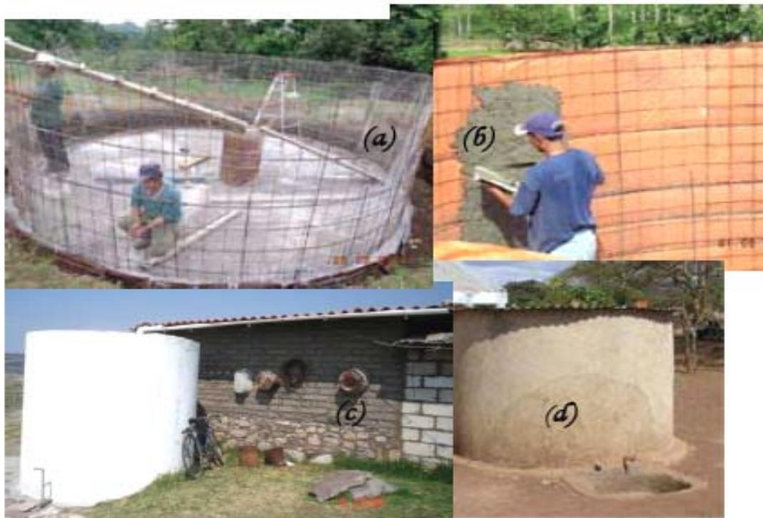
Figura 3.6 Depósito o cisterna de ferrocemento
