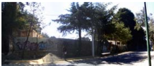
4.2.3.2 Fotografía de la Fachada principal.
