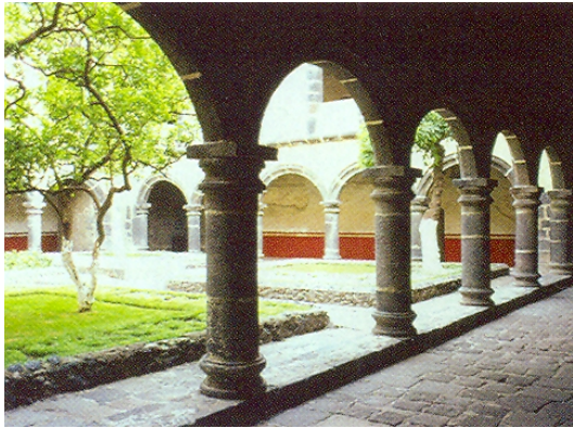
3.1.2 Claustro del Ex Convento de Culhuacán.
