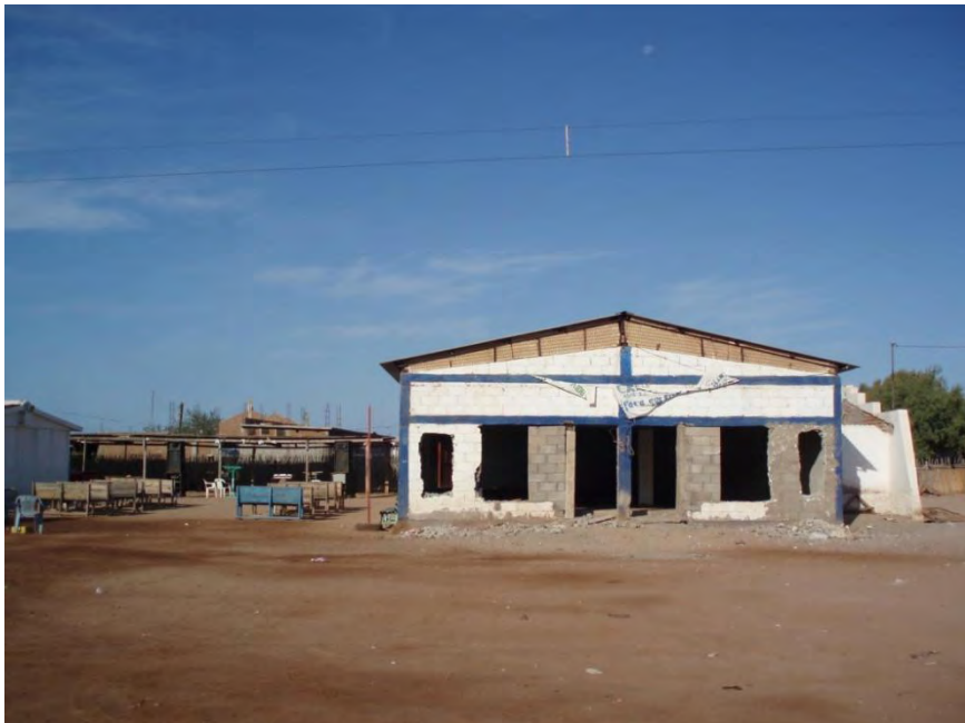
Foto 9. Iglesia Evangélica en remodelación. (Punta Chueca, 2007)
