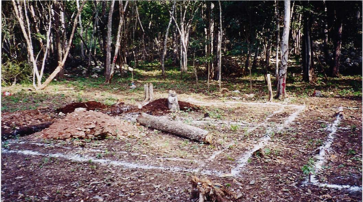
Fotos 15 y 16. Proceso de construcción de las viviendas
