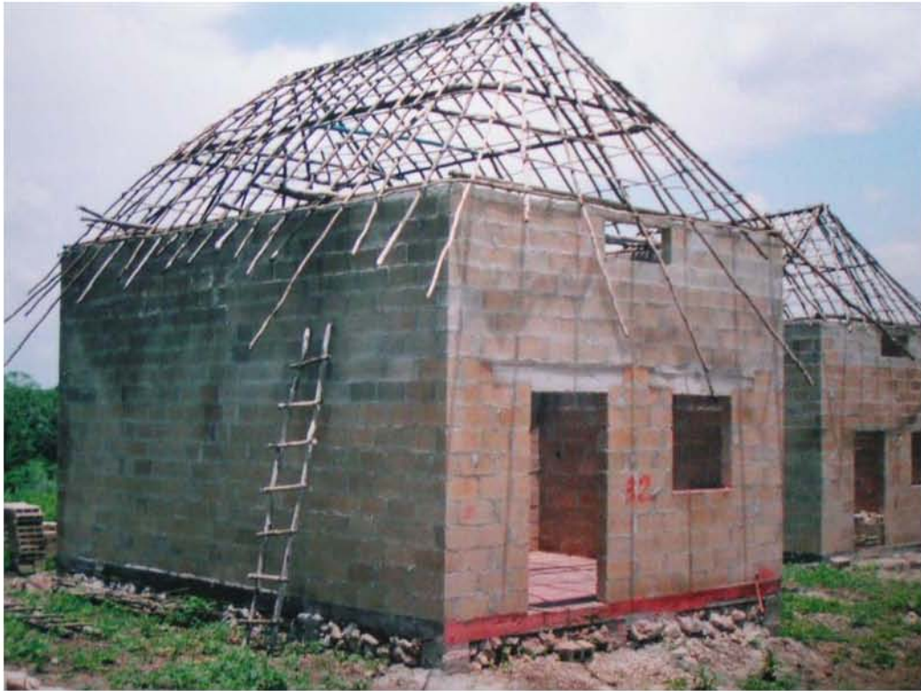
Fotos 17 y 18. Proceso de construcción de las viviendas
