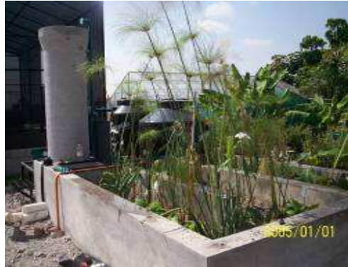
Figura 94. Sistema Combinado de biofiltración y humedal ER
