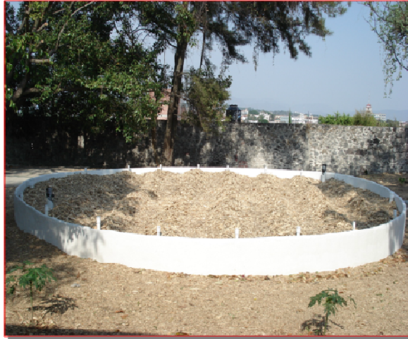
Figura 2.- Biofiltro en la secundaria No 2 de Cuernavaca, Mor.
