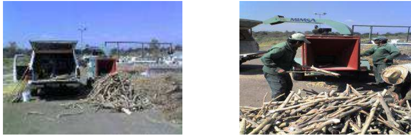
Figura 36 Fotografías proceso de construcción del sistema
