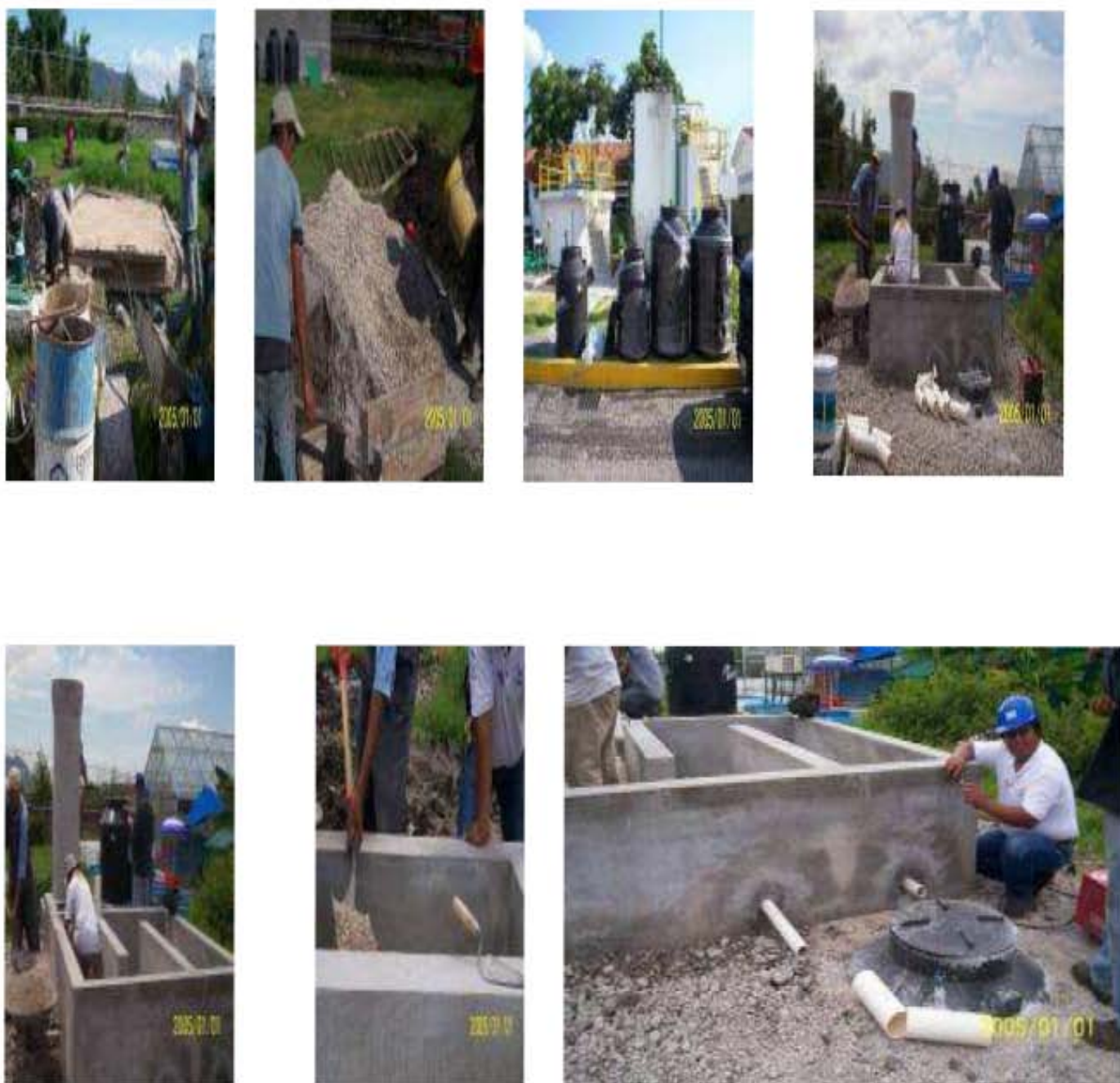
Figura 30. Fotos del proceso de construcción del sistema
