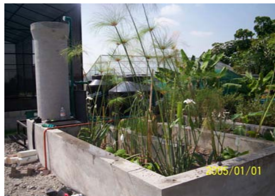
Figura 34 Sistema combinado de tratamiento una vez colocadas las plantas
