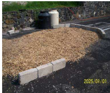
Figura 37. Fotografías proceso de construcción del sistema
