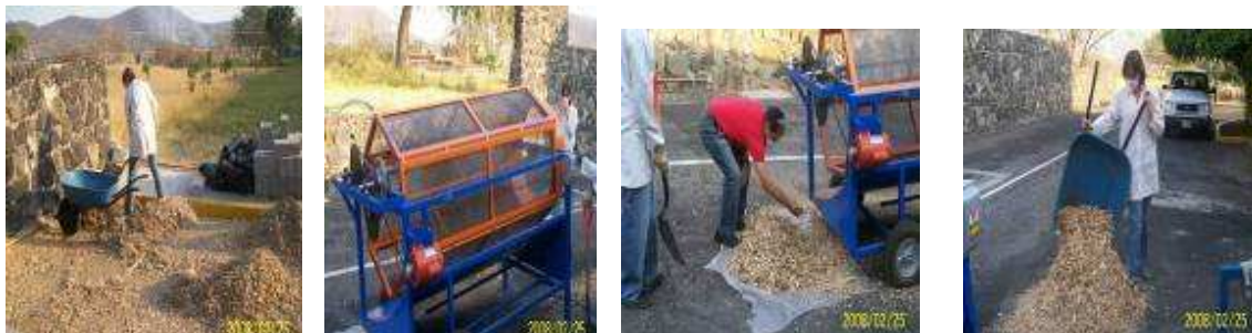
Figura 38. Fotografías proceso de construcción del sistema
