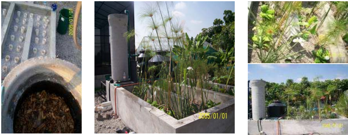
Figura 43. Fotografías sobre la puesta en marcha del sistema de tratamiento
