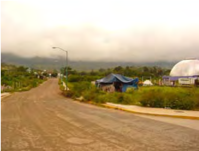
FACHADA LATERAL SOBRE LA CALLE RECLUSORIO ORIENTE
