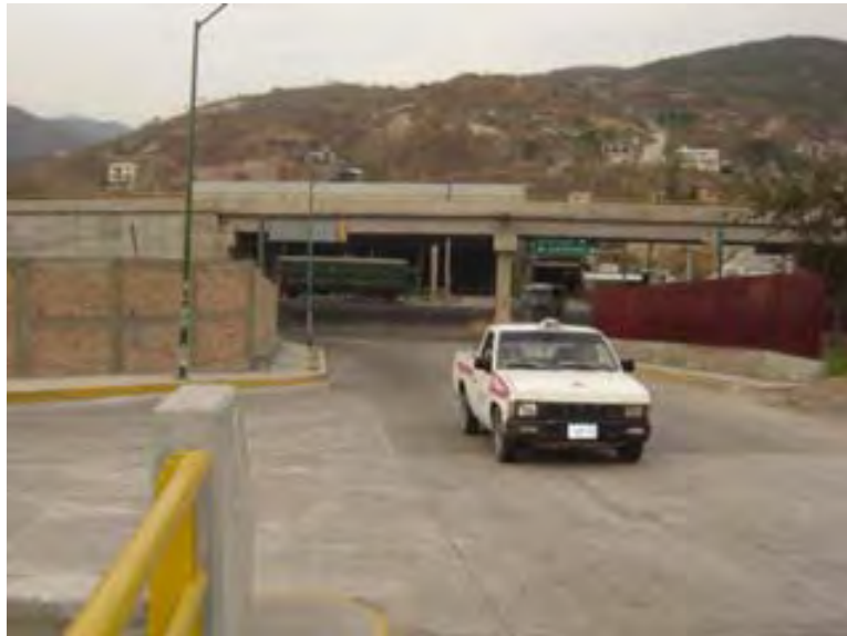
AMPLIACIÓN DEL ENCAUSAMIENTO, QUE CONECTA CON LA AUTOPISTA DEL SOL MEX-ACA
