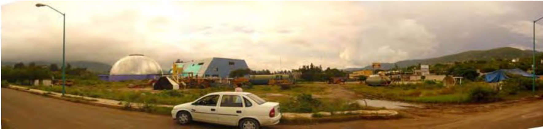
FACHADA LATERAL SOBRE LA CALLE RECLUSORIO ORIENTE
