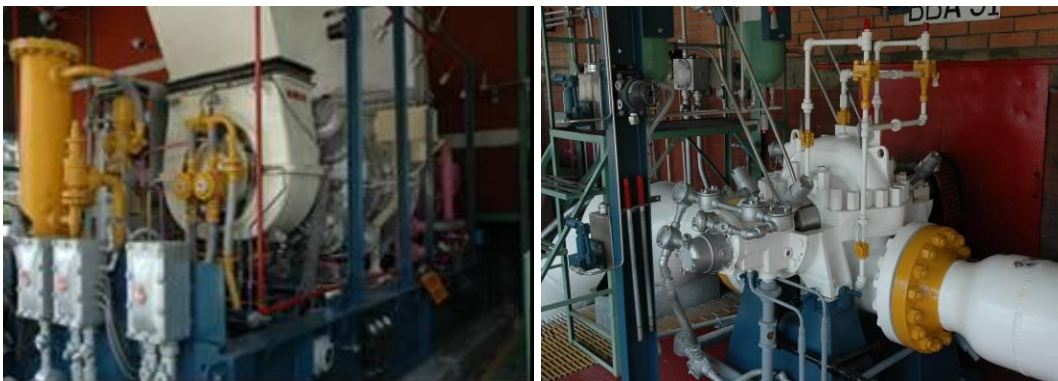
Figura 2.4.S Bombas-turbina.
