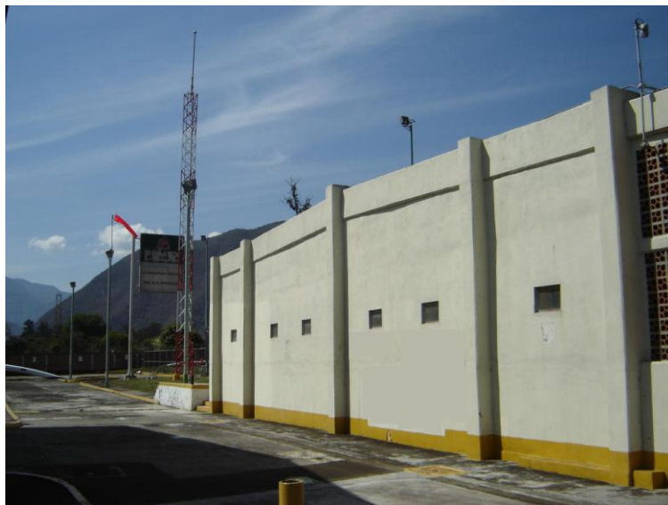
Figura 2.11. Cuarto de control
