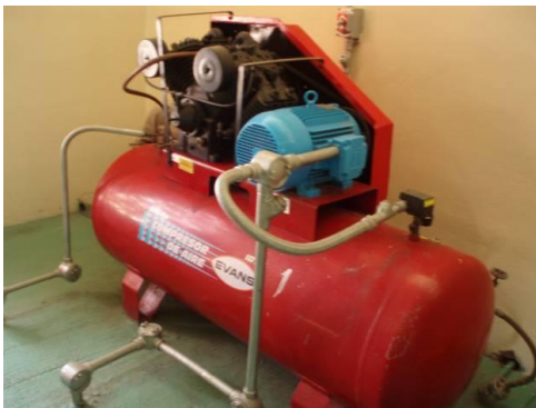
Figura 2.5. Compresor de aire tipo reciprocante portátil
