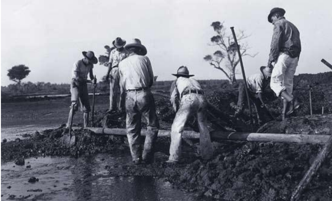
Figura 1.2. Instalación de oleoductos.
