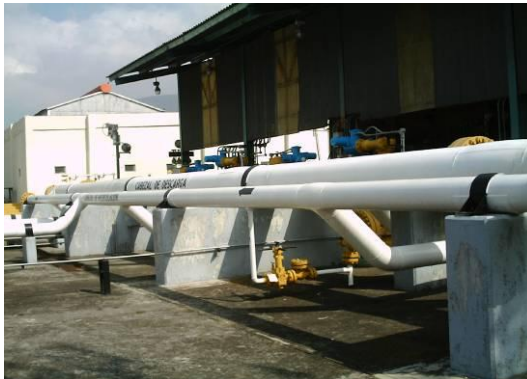
Figura 2.3 a. Cabezal general de succión
