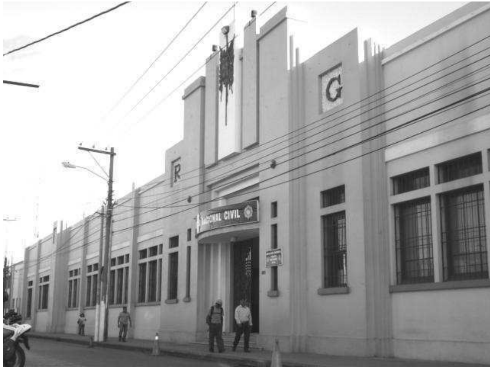
Fotografía No. 45 Panorámica del Edificio de la Antigua Aduana Central.
