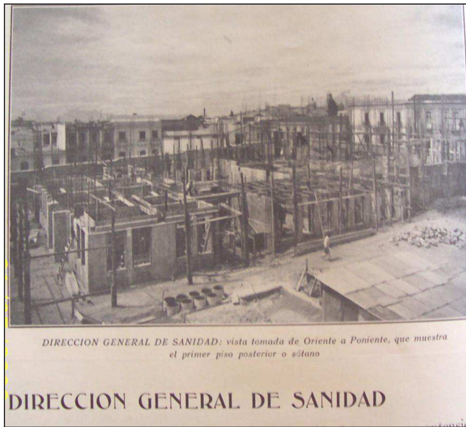
Fotografía No. 39 Etapa Constructiva. Edificio de Sanidad Pública. 1936
