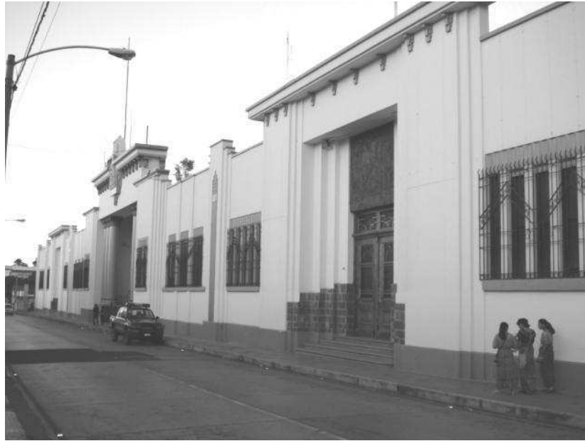
Fotografía No. 40 Panorámica del Edificio de Casa Presidencial.
