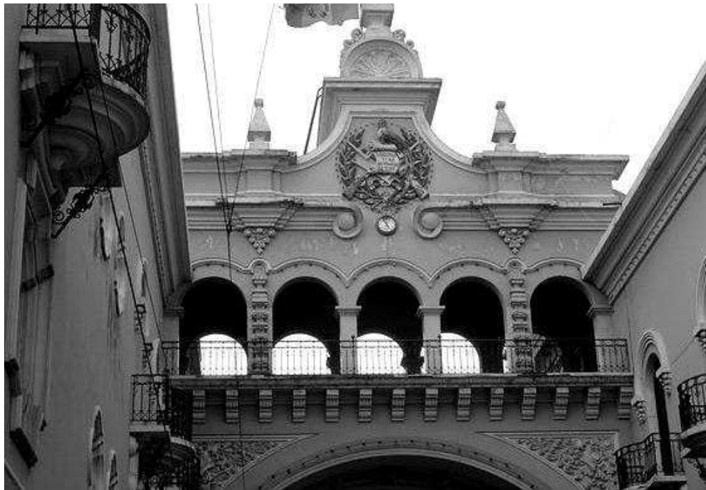
Fotografía No. 28 Arco que comunica el área administrativa con el área postal. Edificio de Correos y Telégrafos.
