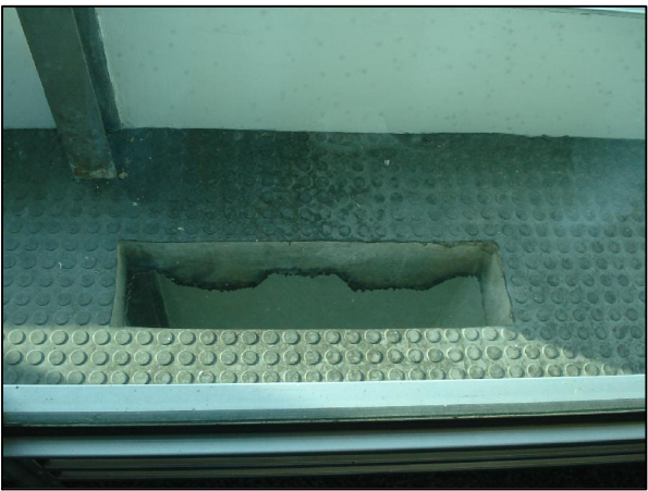
aplicación de cámara de aire, Torre de Ingeniería UNAM
