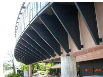
Acercamiento de la estructura del pórtico
