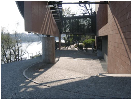
Detalle del puente
