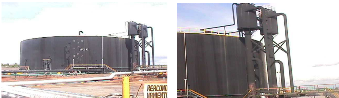
Figura 7.14 Tanques de lavado en su exterior, (Francisco, R., 2000).
