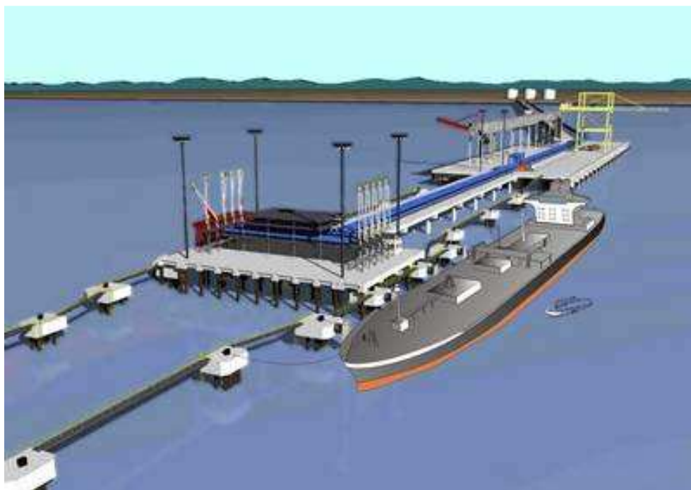
Figura 8.2 Ejemplo de una Terminal petrolera, (Brant, F., 2006).
