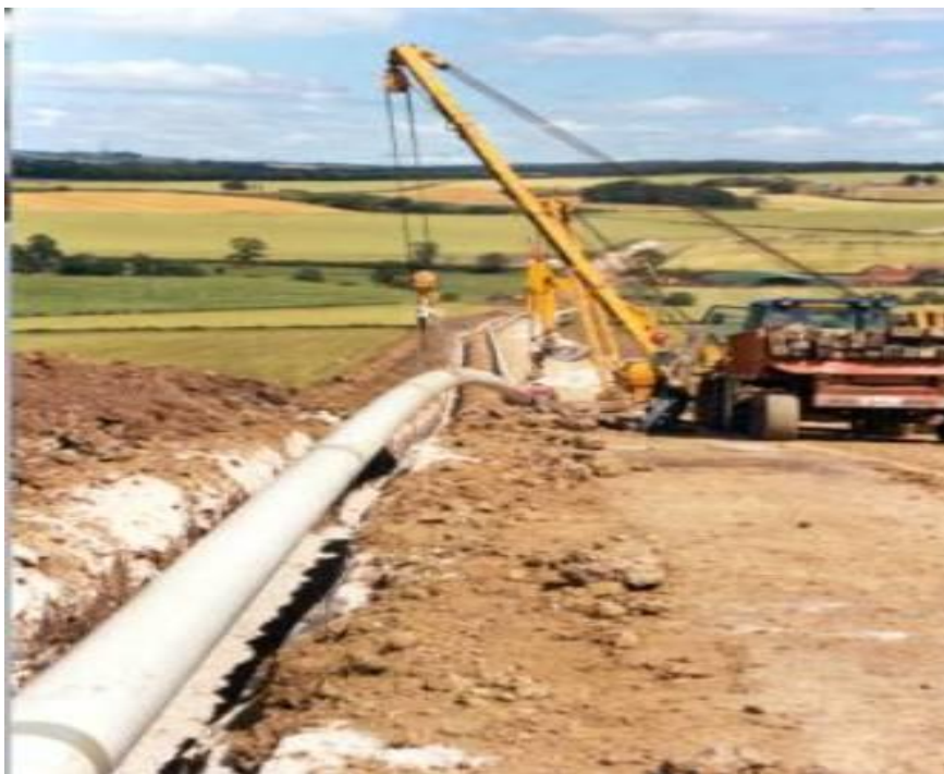
Fig. 1. 14 Instalación de Tubería con Encamisado
