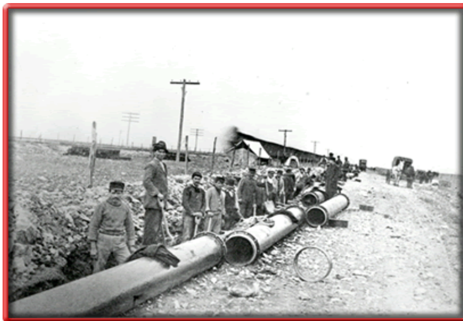
Fig. 1.8 Tubería antes de ser soldada
