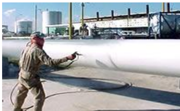
Fig. 2.3 Aplicación de recubrimiento externo
