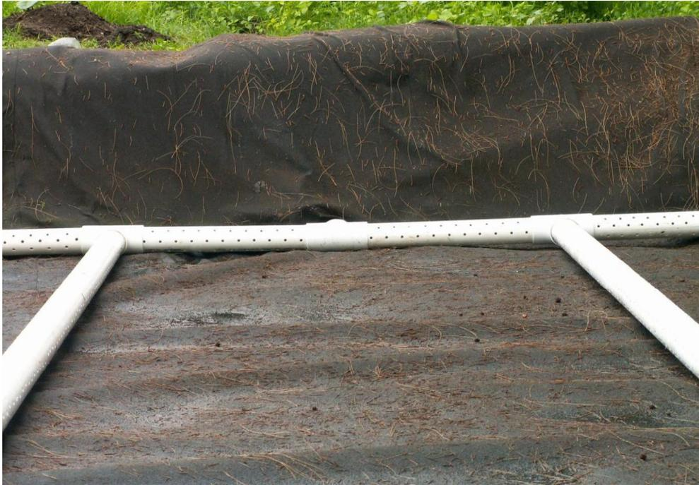
Figura 8. Tubería de drenado horizontal del agua residual a tratar.
