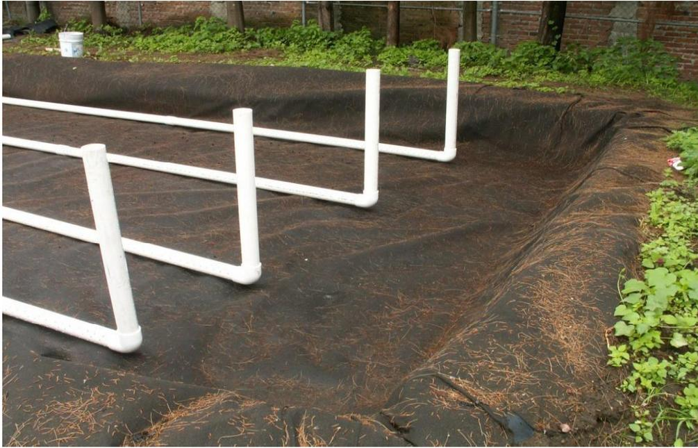
Figura 7. Tubería de drenado vertical del agua residual a tratar.
