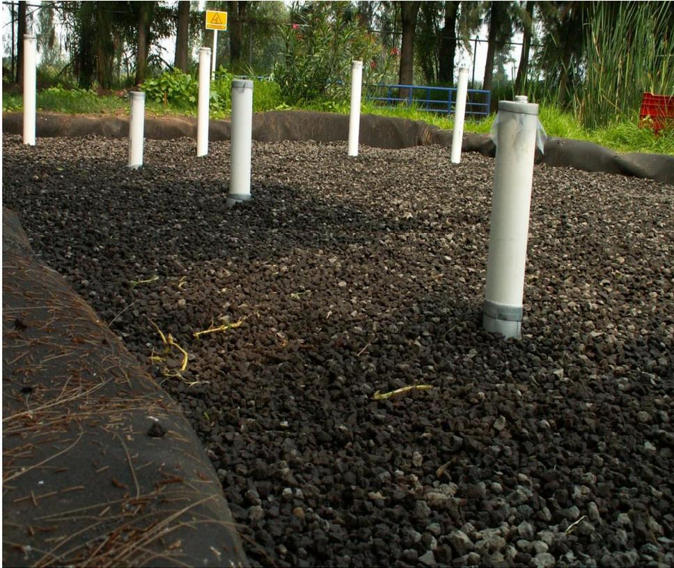
Figura 9. Tubería de aireación y muestreo del agua residual a tratar.
