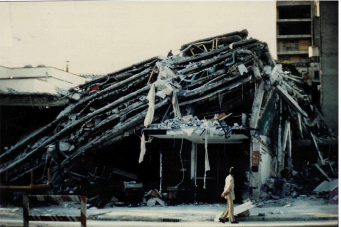
Falla masiva de columnas y destrucción de pisos superiores
