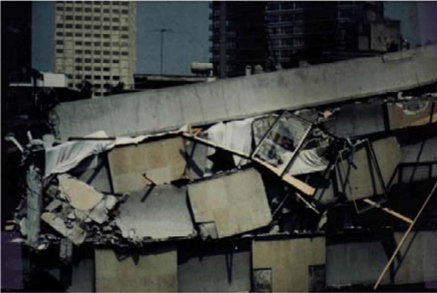
Los constructores con frecuencia ejecutaron los edificios de manera distinta a lo indicado en el diseño estructural, modificando el comportamiento previsto, provocando incrementos adicionales al efecto de la torsión en la estructura.
