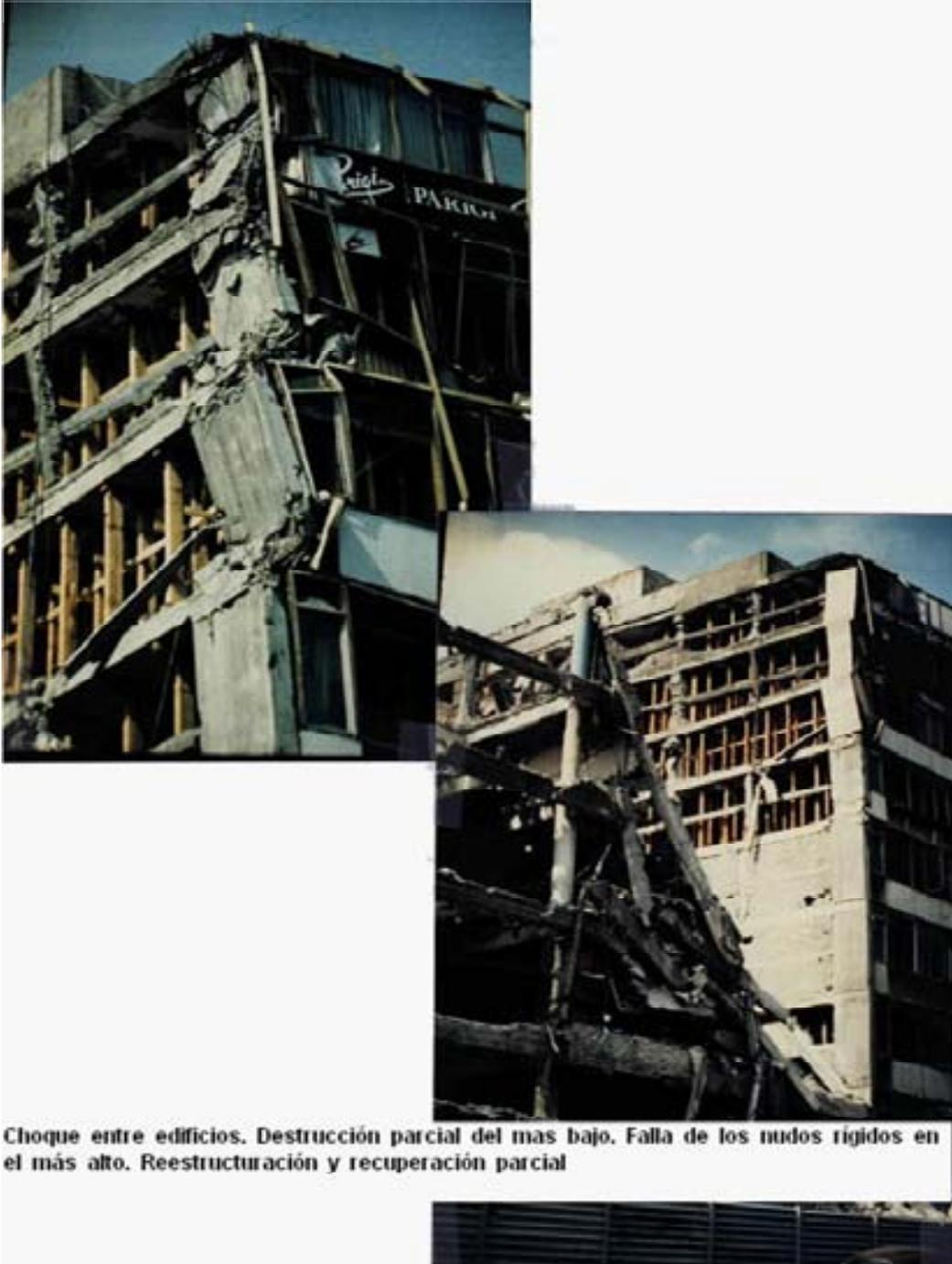
Choque entre edificios. Destrucción parcial del mas bajo. Falla de los nudos rigidos en el más alto. Reestructuración y recuperación parcial
