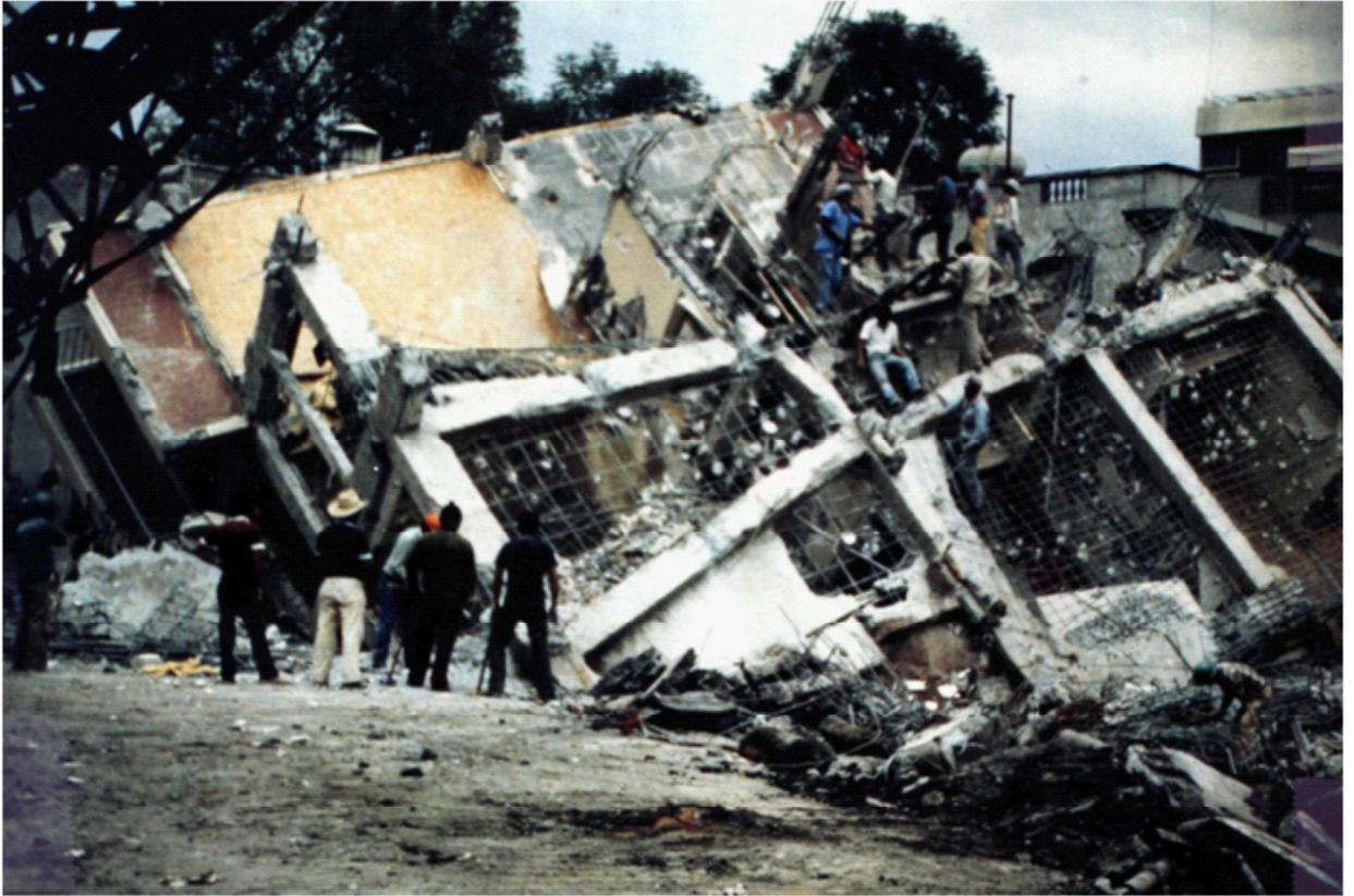
Edificio 10 pisos frente espacio abierto. Falla de pilotes de fricción
