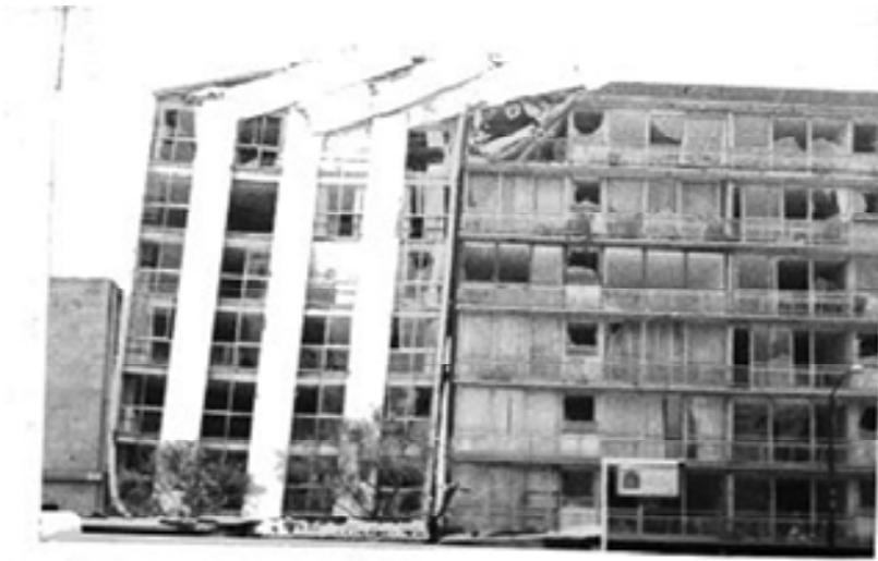
Clara destrucción pisos superiores del edificio alto 9 en choque con 6.
