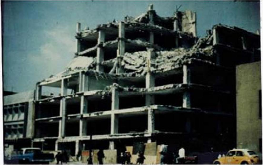
**Clapso por torsión 5 pisos superiores. Núcleo servicios excéntrico
