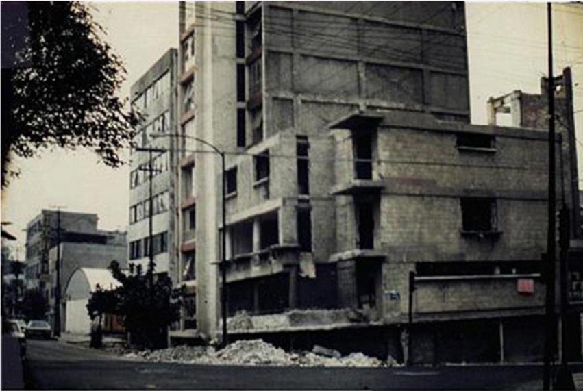
Estructura resistente. Falla al cortante del suelo
