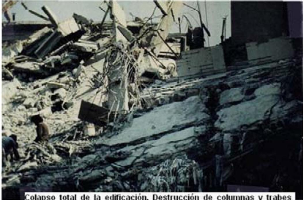
**Colapso total de la edificación. Destrucción de columnas y traves
