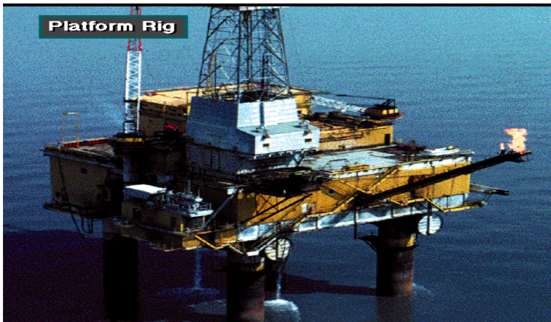
Figura 1. Plataforma de tipo fija
