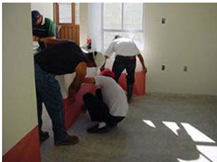
Fig. 4.10. Protección de superficies con enmascarillado
