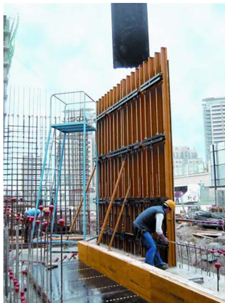
Fig. 2.8. Colocación de una hoja de cimbra metálica
