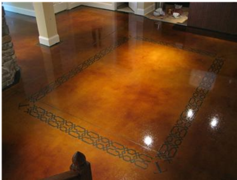
Fig. 4.6. La imagen muestra un piso coloreado a base de ácidos oxidantes de concreto.
