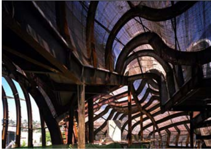
Fig. 2.10. Estructura de acero fabricada por el método CNC. Edificio experience music, Seattle. Arq. Frank Gehry.
