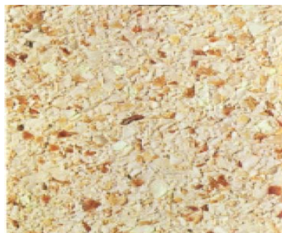
Fig. 3.14. Muestra una sección de concreto con acabado incrustado.
