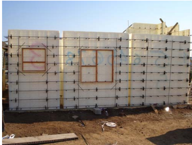
Fig. 2.9. Cimbra de plástico reforzado para su uso en serie
