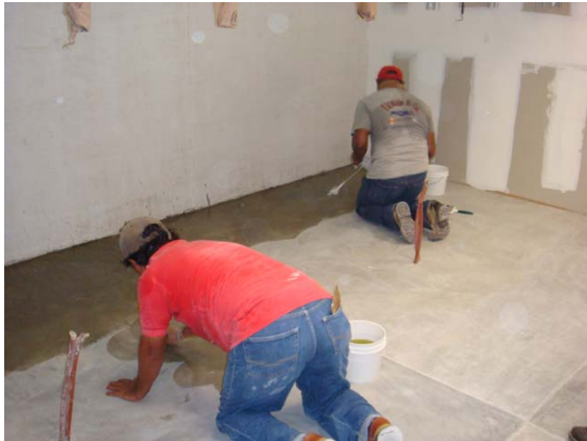
Fig.6.3. Aquí se observa cómo se va aplicando el ácido por medio de una brocha y uniformando el acabado a través de estopa.
