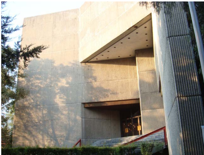
Fig. 3.4. Acabado en concreto con patrones. Sala Netzahualcóyotl, México.
