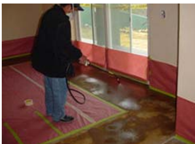
Fig. 4.11. Aplicación del oxidante en un piso.
