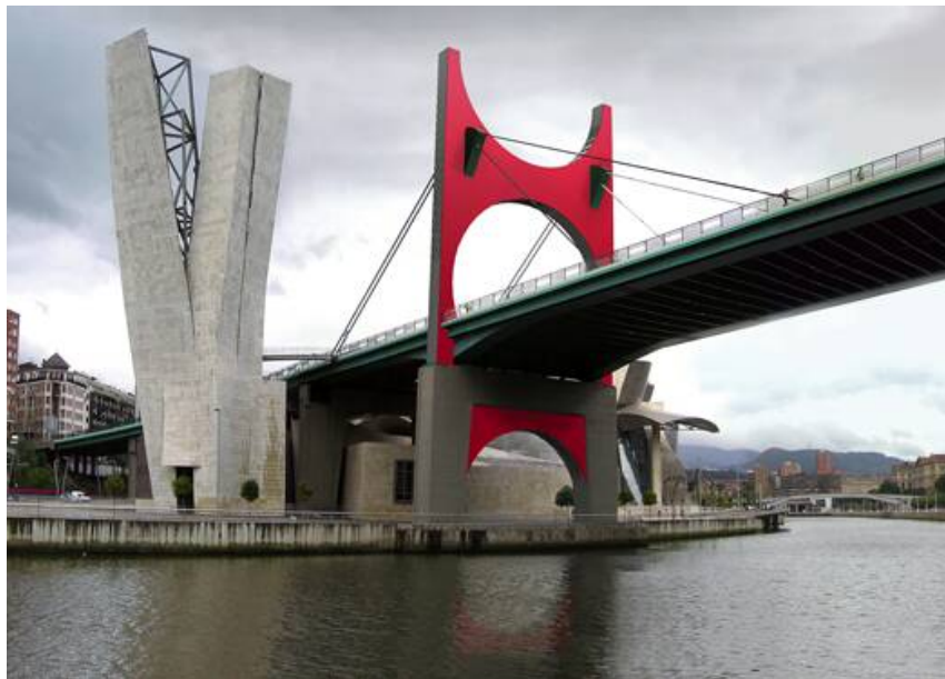
Fig. 4.1. Puente La Salve. Bilbao, España.
