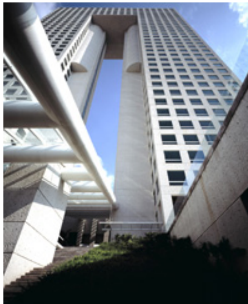
Fig. 3.15. Edificio hecho de concreto blanco con agregado de mármol martelinado. Arcos Bosques, México. Arq. Teodoro González de León
