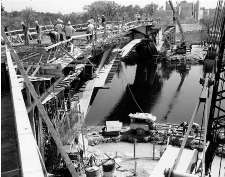
Fig. 2.2. Cimbra en puente Faryon en Trent University, Peterborough, Ontario, Canada.
