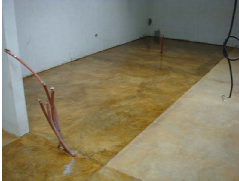
Fig. 6.4. En la imagen se puede observar claramente cómo cambia la tonalidad del piso al agregarle el sellador.
