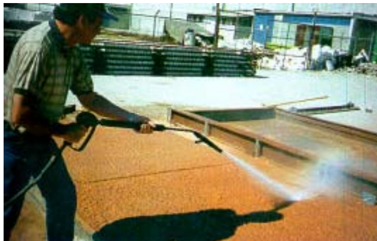
Fig. 3.16. Aplicación de chorro de agua para acabado en el concreto
