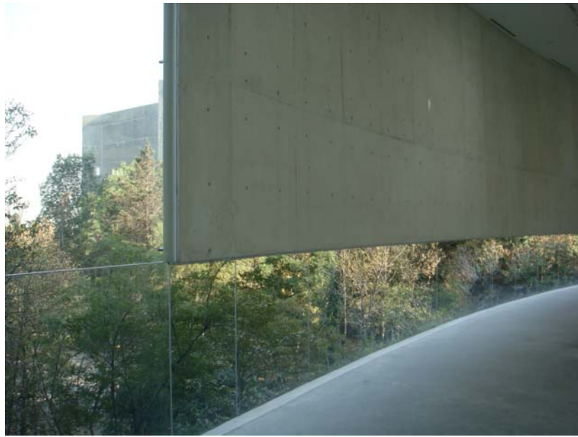
Fig. 2.4. La modulación y el diseño en la cimbra tiene una gran importancia para poder lograr una respuesta estructural adecuada de los elementos, además de poder cumplir con las expectativas arquitectónicas. Edificio MUAC, México, DF.
