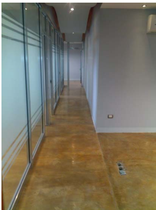
Fig. 6.6. Podemos observar el acabado final en el piso con acido color trigo dorado.
