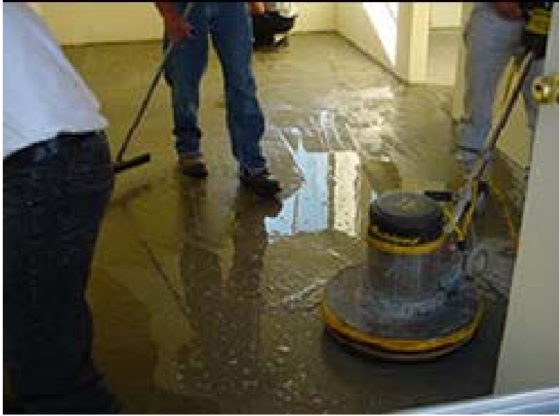
Fig. 4.9. Limpieza de la superficie
