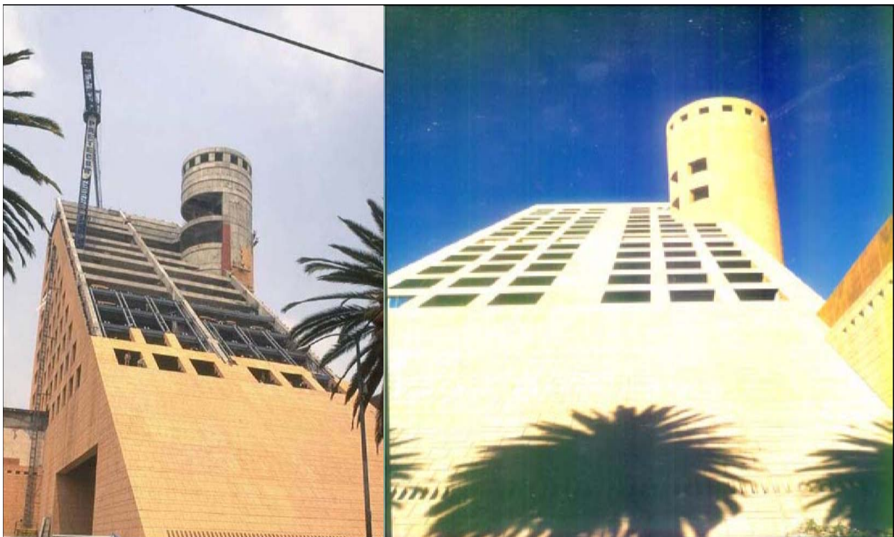
Fig. 3.6. Utilización de paneles de concreto prefabricado. Plaza Moliere 222, México, Arq. Javier Sordo Madaleno.
