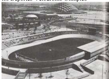
Fuente: Instalaciones Olímpicas, Secretaría de Obras Públicas. 1968.
