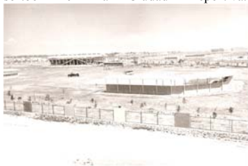
Foto a.3. Construcción de campos de softball en la Ciudad Deportiva.
