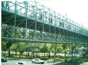
Foto f.2. Puente peatonal ubicado en la Avenida Río Churubusco.
