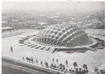
Fuente: Instalaciones Olímpicas, Secretaría de Obras Públicas, 1968.
