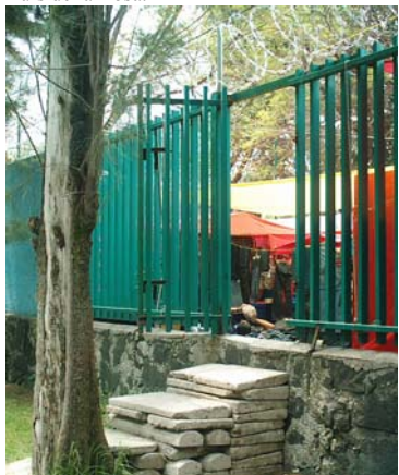
Foto b1. Puerta de acceso sobre la calle Luis de la Rosa.
