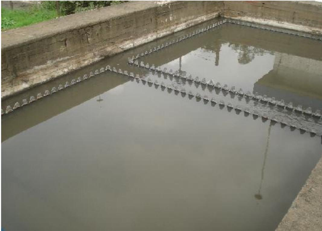
Figura 3.19. Vertedores perimetrales del sedimentador secundario.
