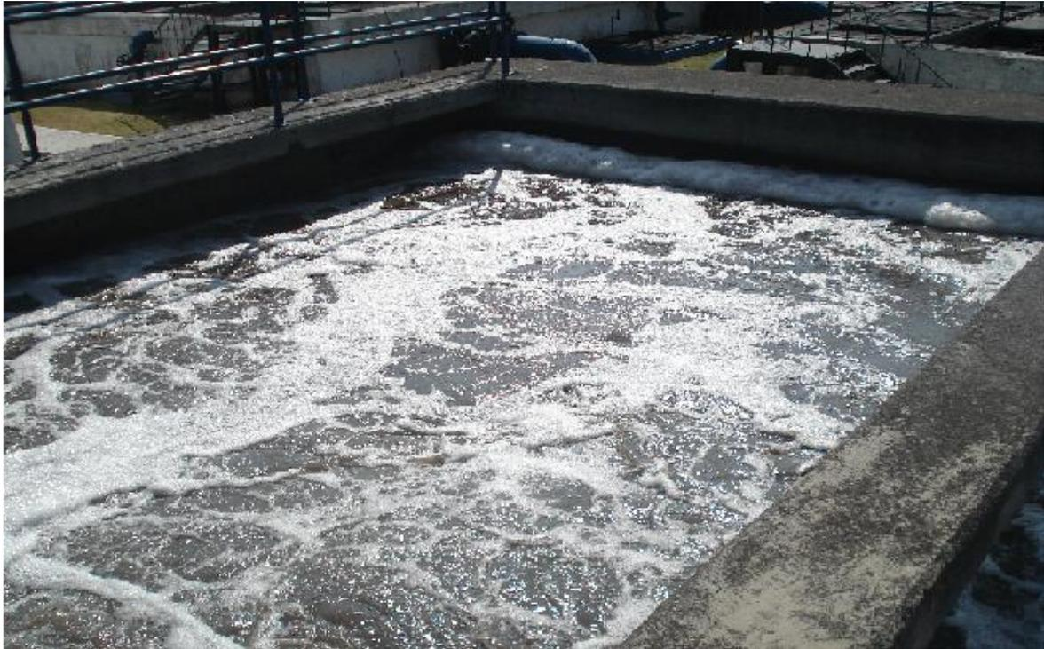
Figura 3.14. Reactor Biológico y difusores para aireación.
