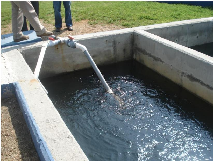
Figura 3.8. Tanque de contacto de cloro.
