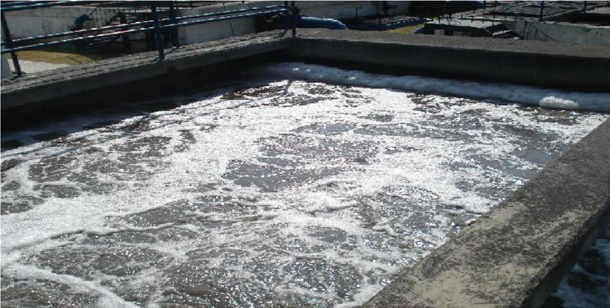
**Figura 3.24 Espumas presentes en el cárcamo de agua cruda, reactor biológico y tanque de contacto de cloro.**
