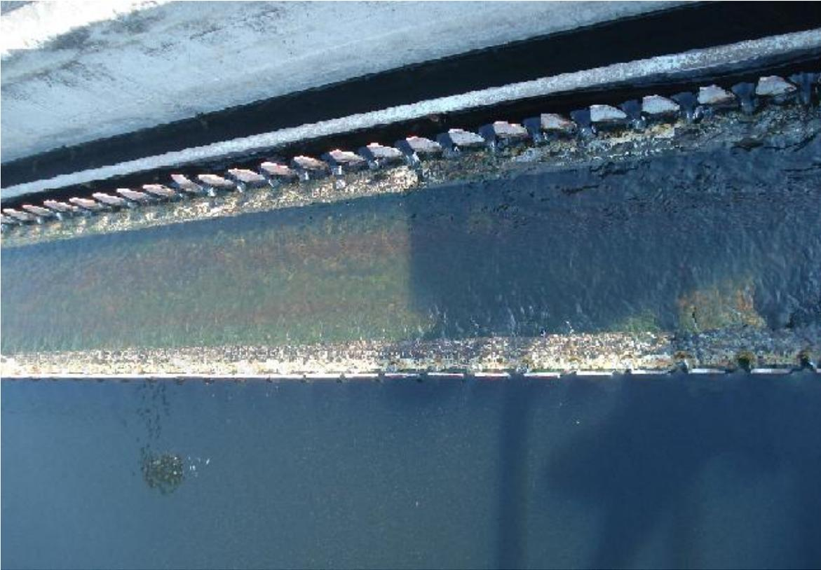
Figura 3.18. Trabes que funcionan como barreras al flujo superficial de agua.
