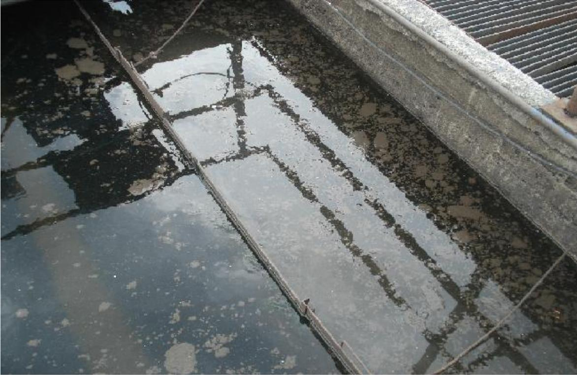
**Figura 3.17. Gran flotación de lodos a lo largo de todo el sedimentador secundario.**
