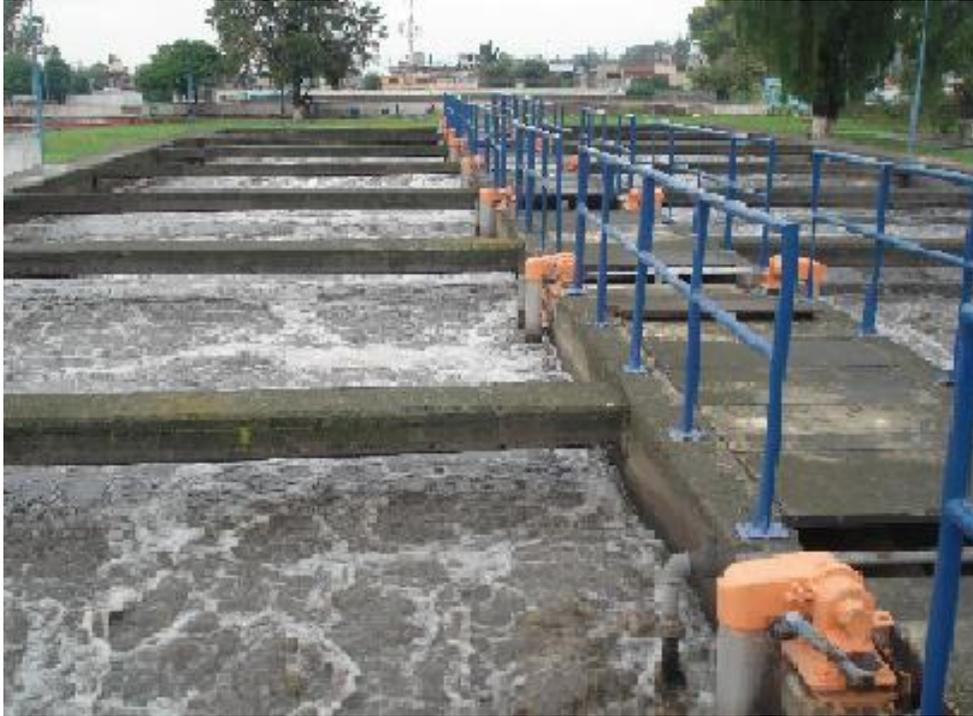
**Figura 3.13. Comunicación entre los dos módulos del reactor biológico.**
