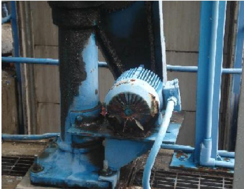
Fig. 3.9 Mal estado de las instalaciones del pretratamiento.
