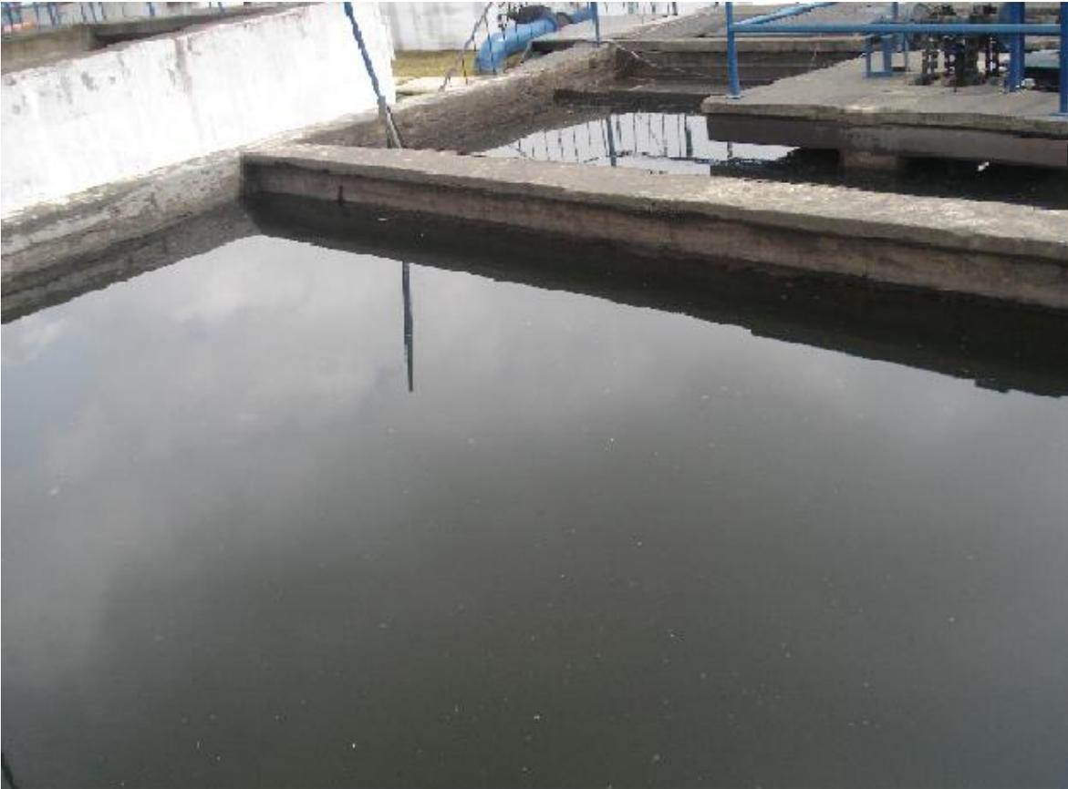
Figura 3.15. Sedimentador secundario.
