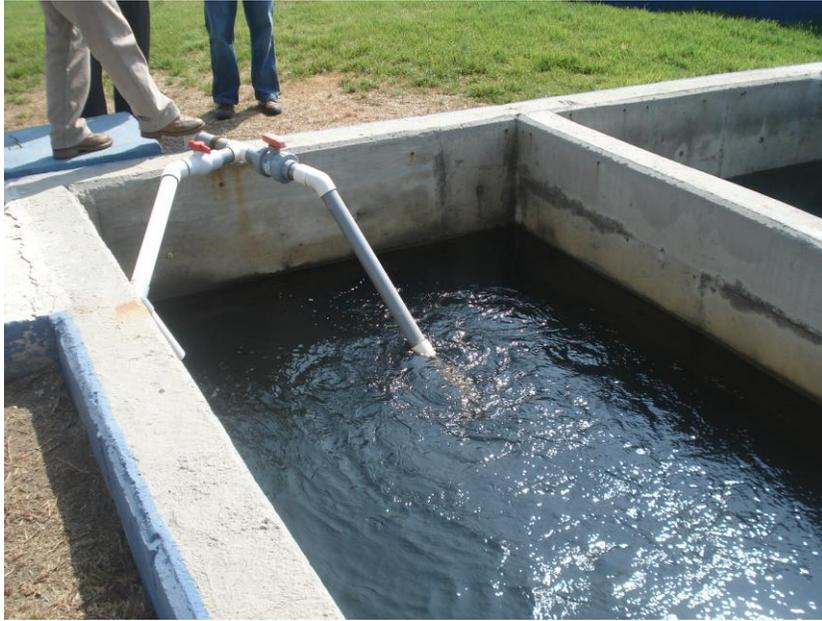
**Figura 3.20. Tanque de contacto de cloro.**
