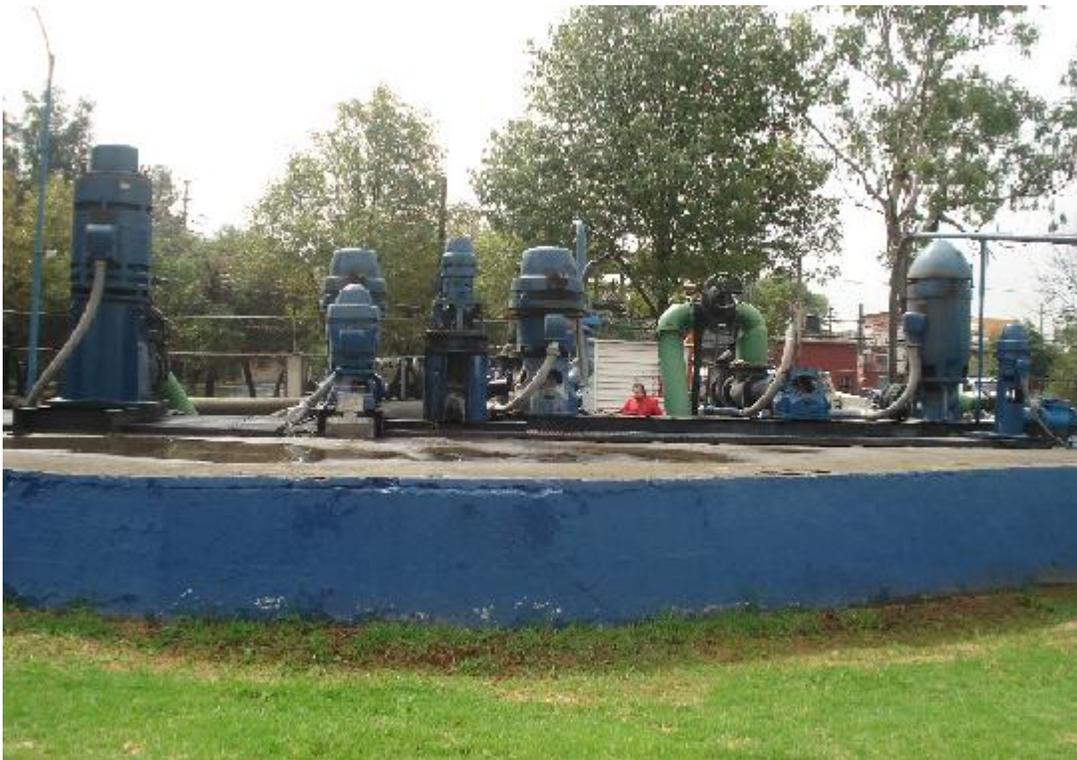
Figura 3.7. Nuevo cárcamo de bombeo de agua tratada, con sólo 5 bombas y cárcamo construido.
