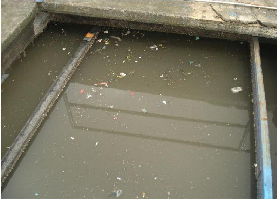
Figura 3.11. Sedimentador primario y basura y natas almacenadas por el mal funcionamiento de las rejillas.
