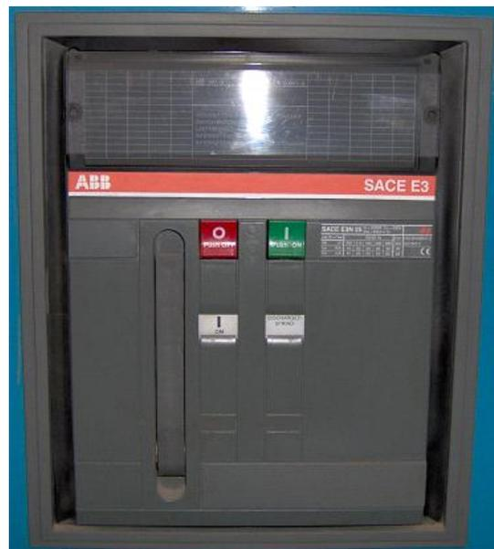
Interruptor general de baja tensión. De navajas o termomagnético en subestaciones con transformadores de 15 a 150 KVA y 220/127 V. En subestaciones de 225 a 2, 500 KVA se instalan los interruptores de potencia en aire tipo H-3.
