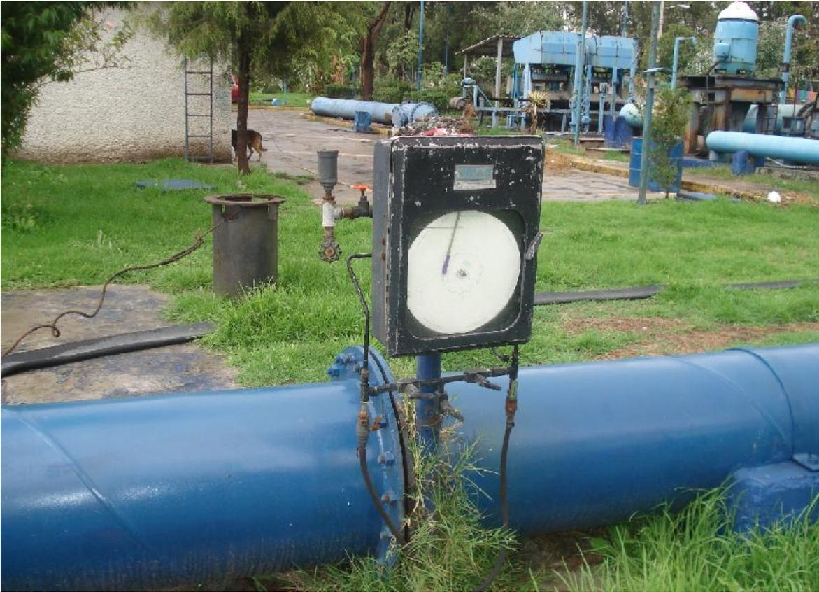
Figura 3.27. Medidor de caudal automático, instalado a la salida del tanque elevado.
