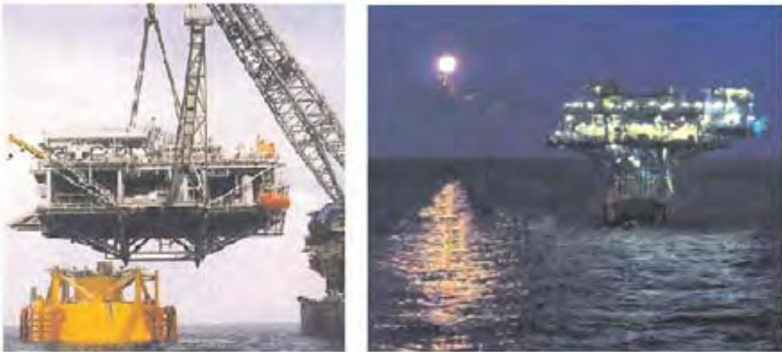
Figura 3. Plataforma Tipo Seastar, Instalación y operación. Ref. [ 2 ]
