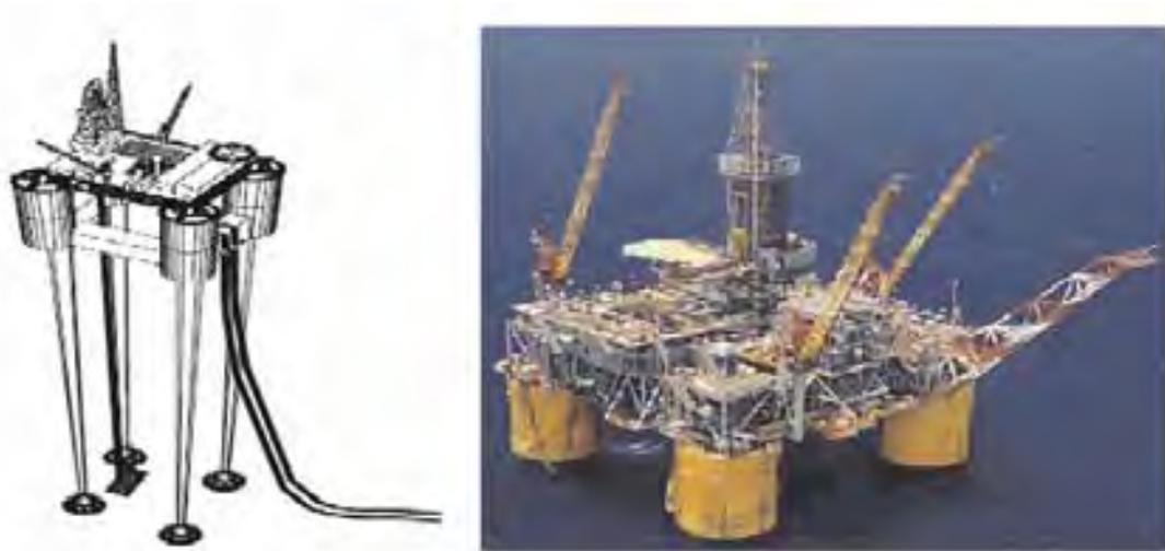
Figura 2. Plataforma tipo TLP en operación. Ref. [ 2 ]
