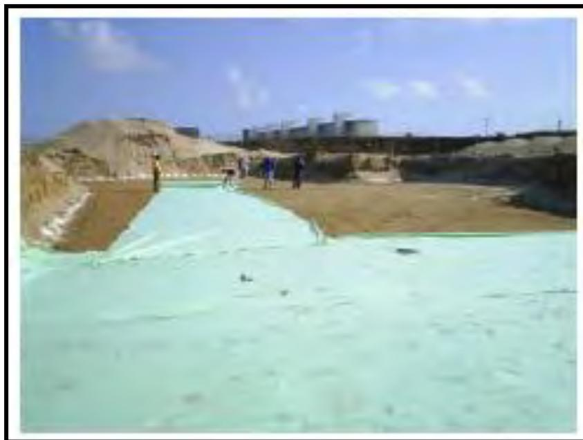
**Figura 12 Colocación de geotextil**
