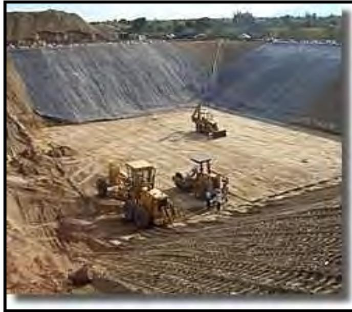
**Figura 4 Construcción del Relleno Sanitario “Método de Trinchera”**
