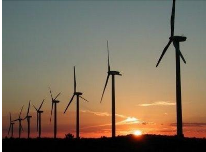
Figura 1.4. Generadores eólicos ANES 2009.
