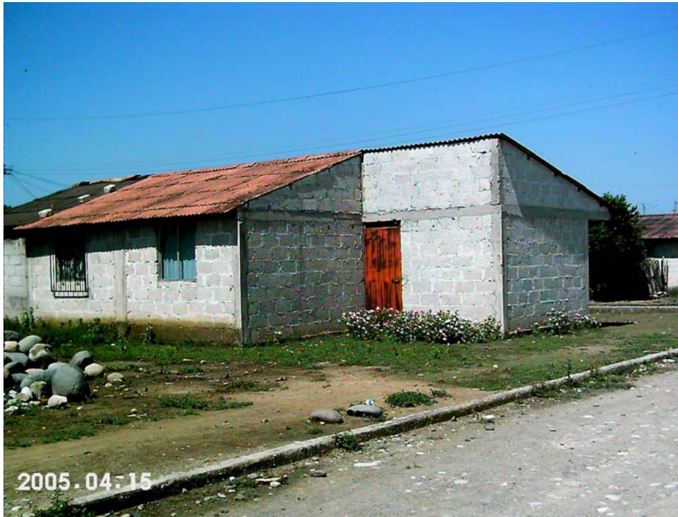
Imagen 12. Viviendas en La Nueva Junta Arroyo Zarco Foto: María del Rayo Campos
