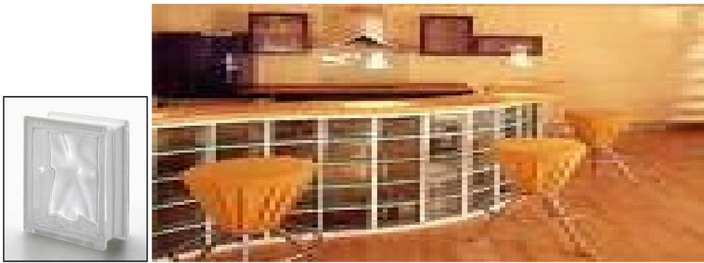
FIGURA 7: Barra de ladrillos de vidrio.
