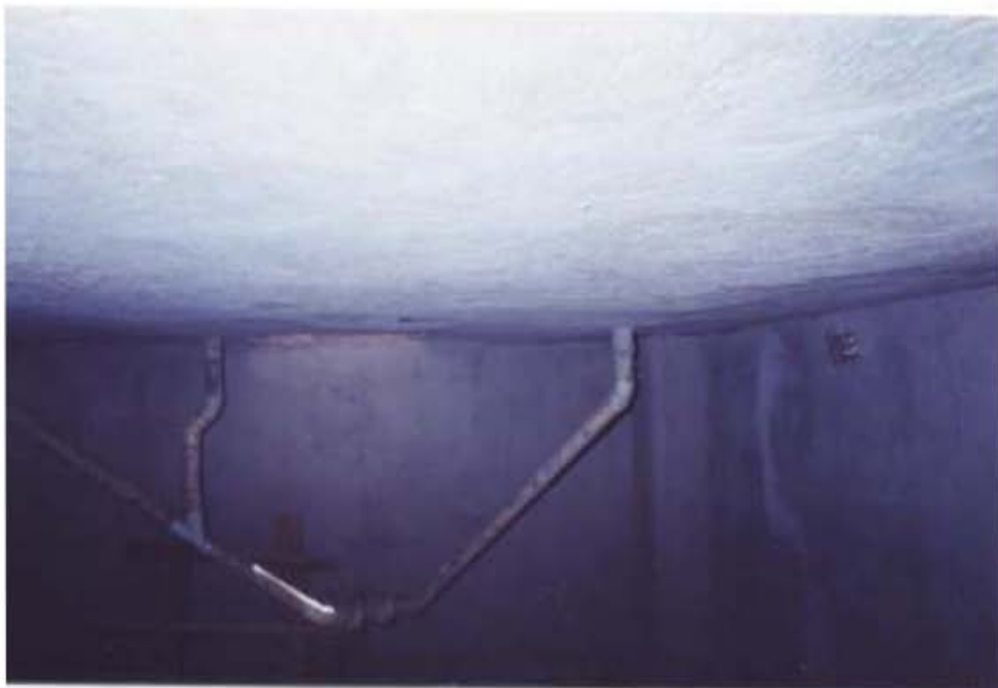
Colocación de polducto para instalación eléctrica
