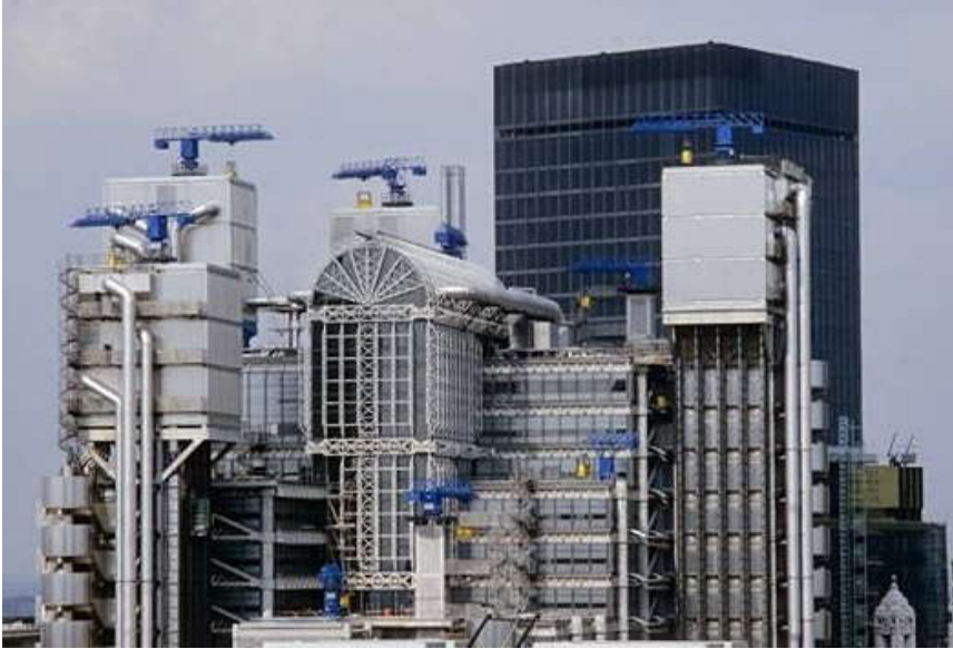
ARRIBA: Vista exterior de la Compañía Lloyds del Arq. Richard Rogers.
