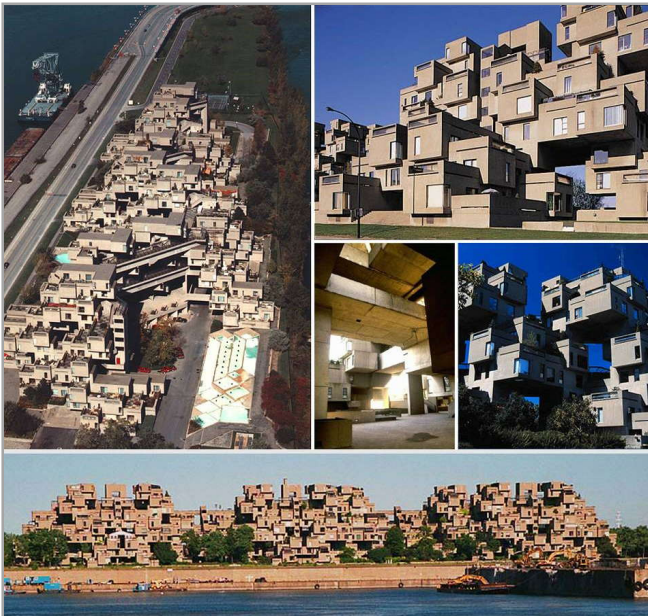
ARRIBA: Habitat de Montreal del Arq. Moshe Safdie, cuya construcción tiene el principio de una geometría fractal lineal, maneja conceptos de células aglomeradas y sobrepuestas entre sí para ir desarrollando una autosimilitud fractal lineal.
