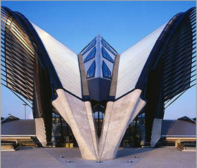
ARRIBA: Aeropuerto de Lyon del Dr. Santiago Calatrava, tiene sus principios estructurales en la forma biónica de la naturaleza y su comportamiento estructural está sometido a la figura orgánica de esqueleto.
