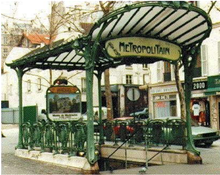
ARRIBA: Vista exterior de la entrada del Metro en París.
