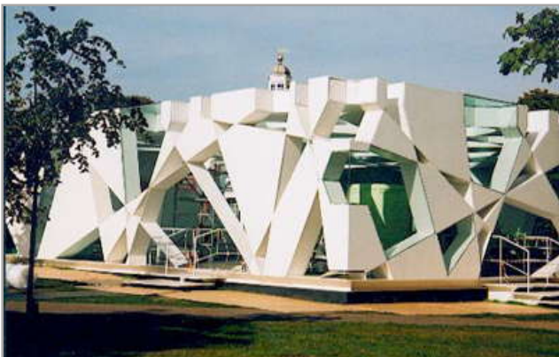
ARRIBA: El Pabellón de Serpentine, de Toyo Itto, cuyo edificio tiene su principio estructural en base a la fragmentación triangular, su geometría es algorítmica, la cual hace que sea un fractal complejo, su desarrollo estructural tiene el principio de generar marcos rígidos sobrepuestos.
