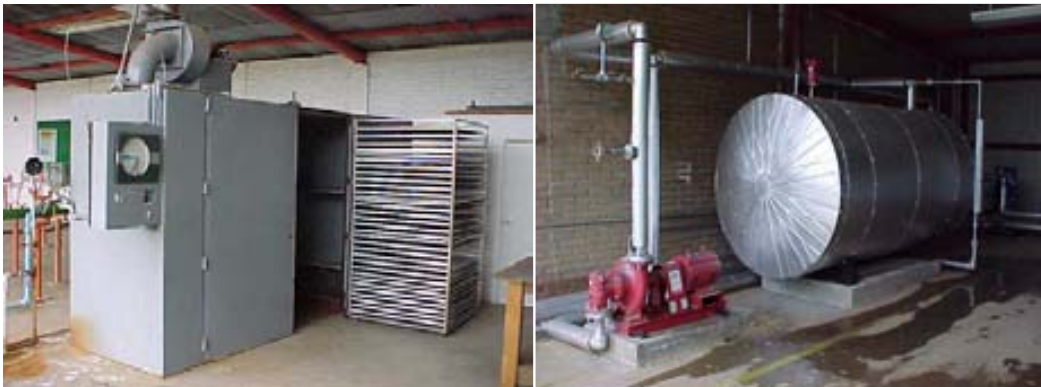
Deshidratador de frutas y tanque de agua caliente en Los Azufres, Michoacán [El autor]
