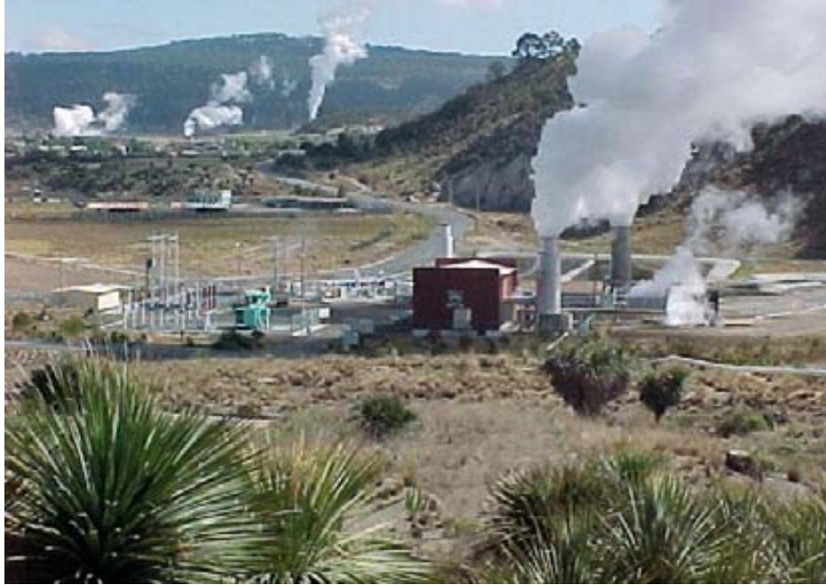
Campo geotérmico “Los Humeros” [IMPULSA 2006]
