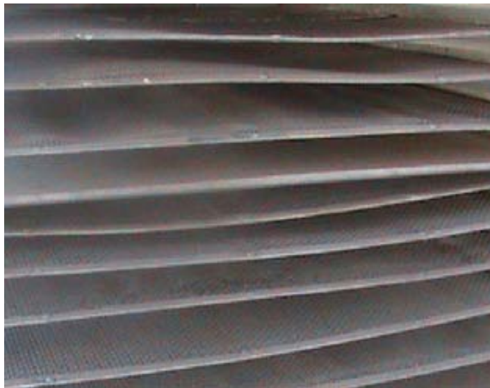
Bandejas en el deshidratador de Los Azufres 2008 [El autor]
