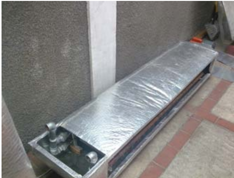
Vista del túnel de calefacción.
