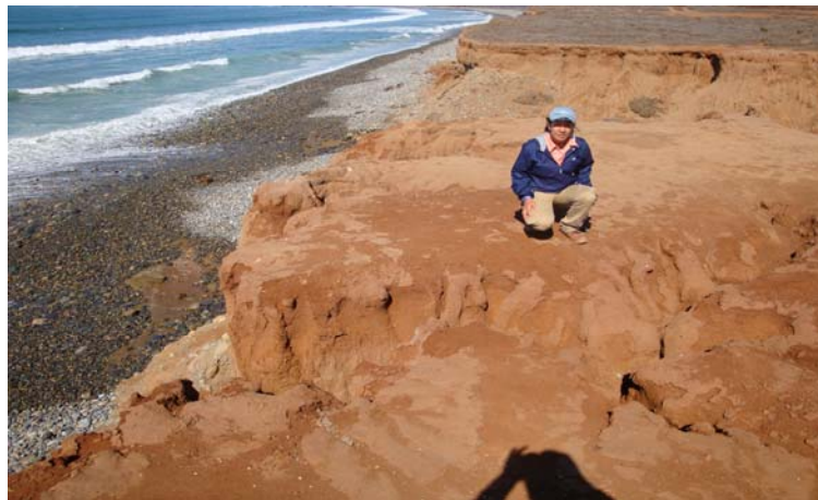
Fotografía 2.9. Presencia de grietas de tensión en la terraza aluvial.
