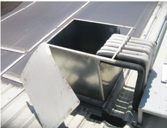
Fig. 7.17a- Estructura metálica no puesta a tierra, incumpliendo el Art. 250-32, sección D de la norma NOM-001-SEDE-2005.
