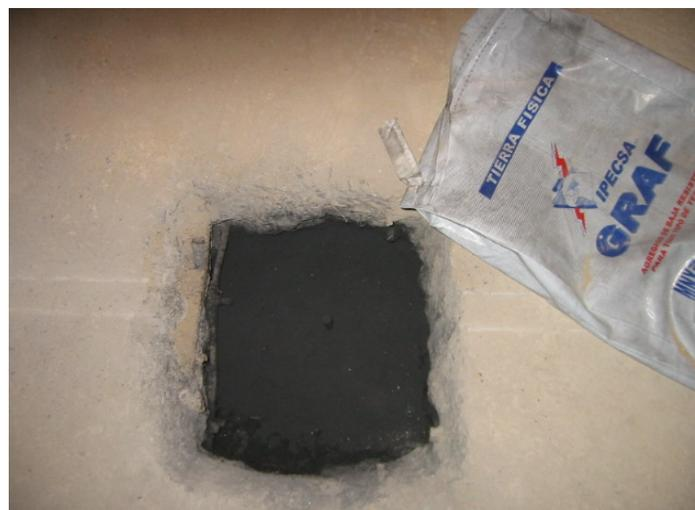
Fig. 1.19.- Bulto de compuesto GEM.
