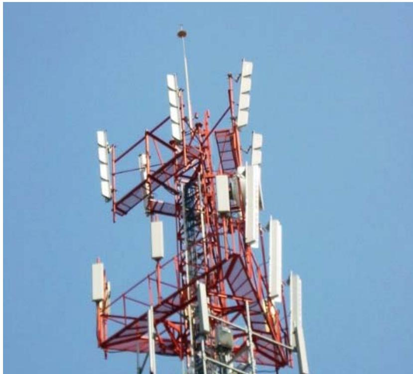
Fig. 3.2.- Ejemplo de antena receptora de señales, con pararrayos.
