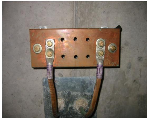
Fig. 2.11.- Barra de unión de cobre con zapatas de doble ojillo.
