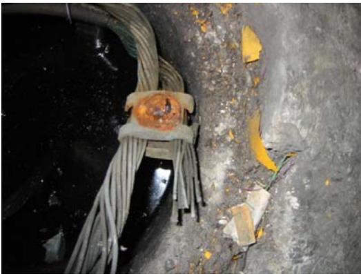
Fig. 7.1.- Sistema de puesta a tierra en mal estado. Se nota presencia de óxido en conector y conductores, además de presencia de suciedad en el registro de medición tipo circular.
