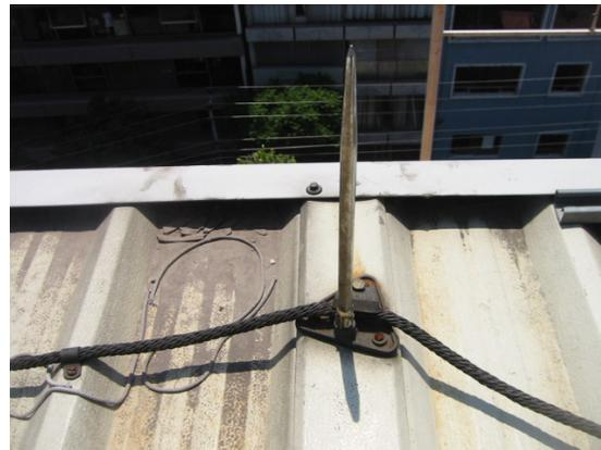
Fig. 7.20b.- Punta pararrayo 0,3 [m] ya instalada.
