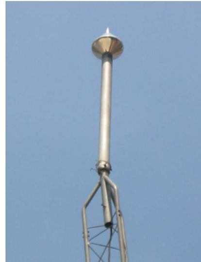
Fig. 7.15.- Punta pararrayo existente.
