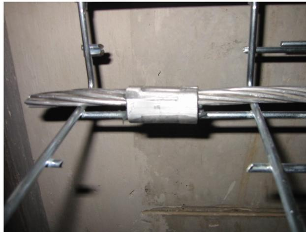
Fig. 1.3.- Conexión de Soporte tipo rejilla con conector mecánico.
