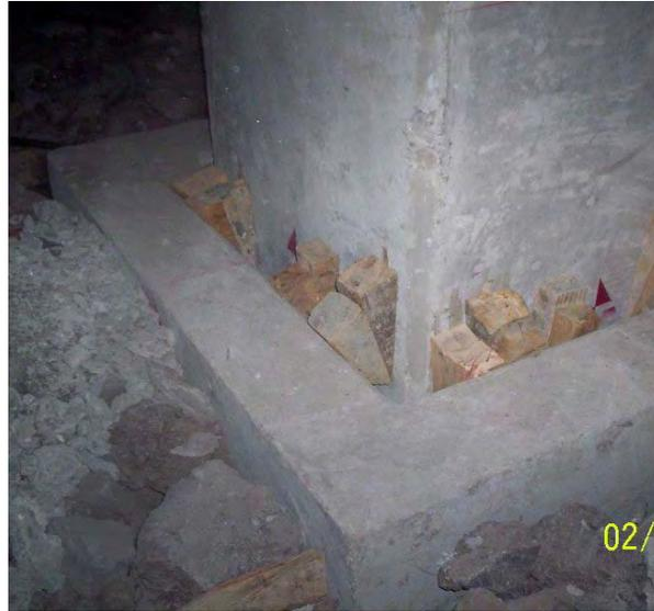
*FIGURA 21. UNIÓN DE COLUMNA A LA CIMENTACIÓN*
