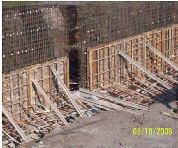
*FIGURA 22. MUROS DE CONTENCIÓN*
