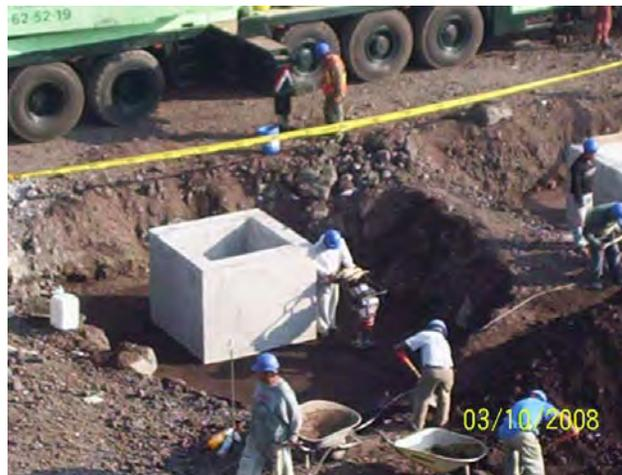
*FIGURA. 12 CIMENTACIONES, DADOS DE LAS ZAPATAS AISLADAS*
