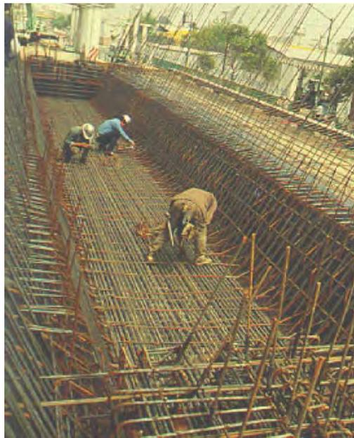
*FIGURA 25. ARMADO DE TRABES*
