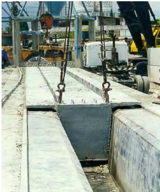
***FIGURA 29. DESMOLDE DE ELEMENTOS PRECOLADOS***
