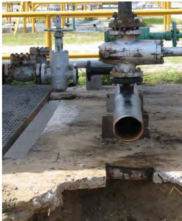
Figura IV.3 Línea de escurrimiento de 8" del pozo A.
