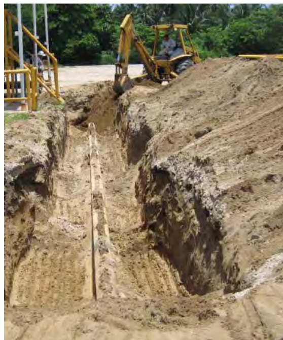
Figura IV.6 Línea de escurrimiento de 8" que presentó depósito de asfalteno, correspondiente al pozo A.
