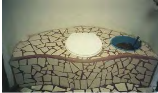
Figura 3.1 Sanitario ecológico seco.
