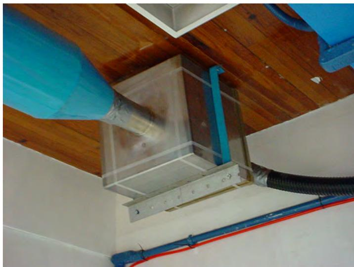
Figura 2.9. Filtro de carbón activado conectado al DISER
