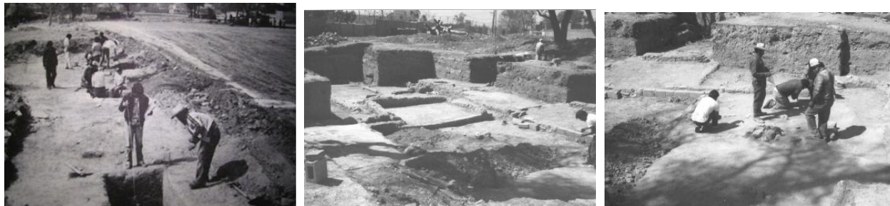
Excavaciones en el Predio "Van Beuren" LINEA 7 DEL METRO- ZONA HABITACIONAL TIPO TEOTIHUACANA
