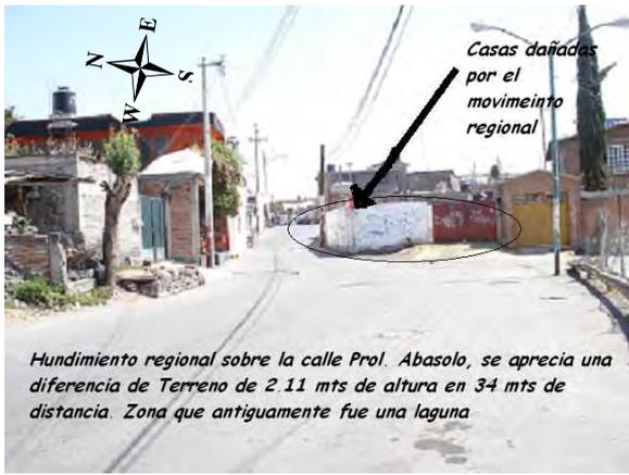
Figura 61. Desnivel del terreno a razón de 2.11 m a 48 m del la Av. Independencia.
