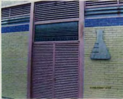
Bodega de sustancias
