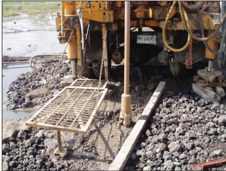
Con los resultados de los SE se construyó un perfil estratigráfico, definiendo las profundidades de muestreo inalterado. La recuperación de las muestras inalteradas de los estratos representativos se realizó mediante el hincado a presión de tubos de pared delgada (tubos Shelby), colocados en la parte inferior de las barras de perforación.
