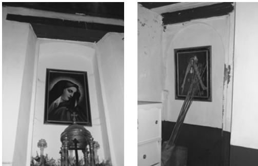
Fotos 15 y 16. Área posterior del presbiterio de la capilla de Santa Crucita; espacio que probablemente fue antes un presbiterio de la capilla abierta, ya que sus sistemas constructivos corresponden a la capilla primitiva. Cuenta con dos accesos tapiados hacia la nave de la capilla y un vano que coincide con la ubicación del retablo, lo que significa que antiguamente pudo estar abierto. Fotografías de DRLT, 2005.
