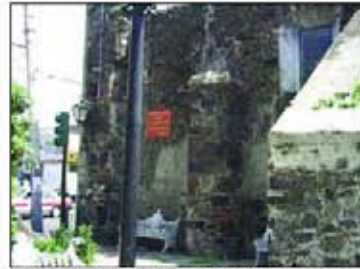
La falta de consolidación en los muros sin aplanados, se resolvió con resane de mezcla cemento arena, ocasionando un acelerado deterioro, se aprecia el aplanado original de cal arena por ligeros vestigios, ubfandas en la cubierta del arco del contrafuerte y en las almenas.
