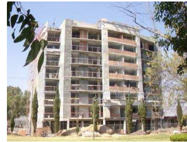
Fachada Oriente de la torre ya terminada.
