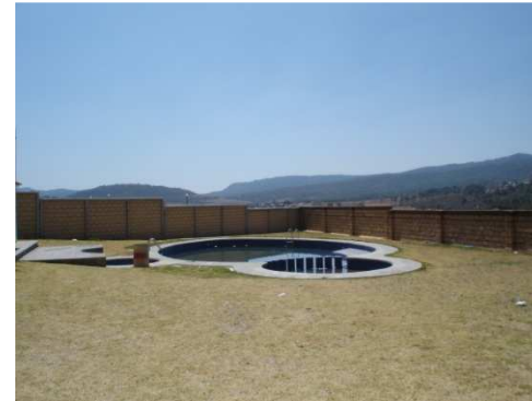
Barda perimetral y alberca.
