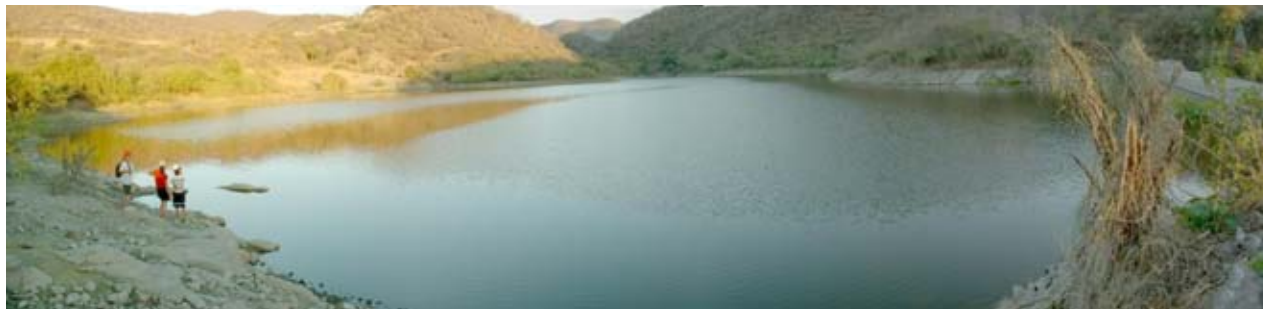
Figura 157. Presa Pablo Torres Burgos, Junio 2007
