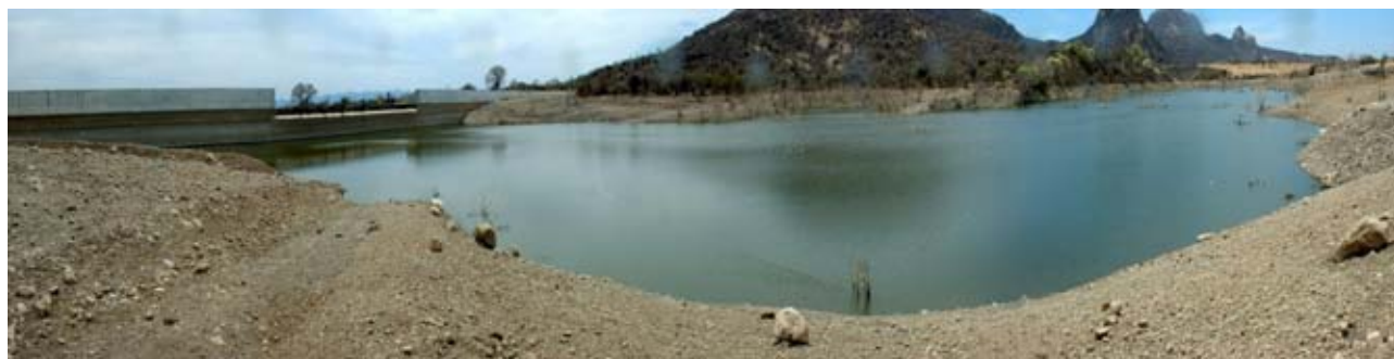
Figura 56. Presa El abrevadero, Abril 2007
