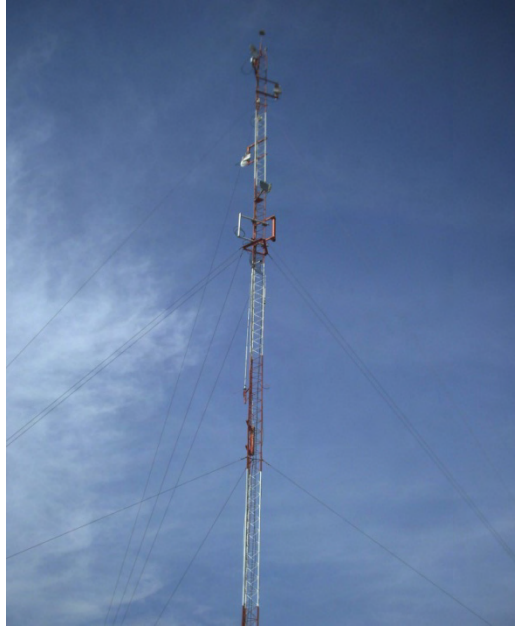
Fig. 3. 15 Vista Panorámica de la torre de comunicaciones DGSCA
