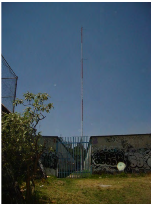
Fig. 3. 23 Vista General de la Estación JARBO
