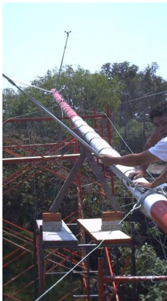
Fig. 3. 22 Andamios levantaron el extremo de la torre al inicio de maniobra
