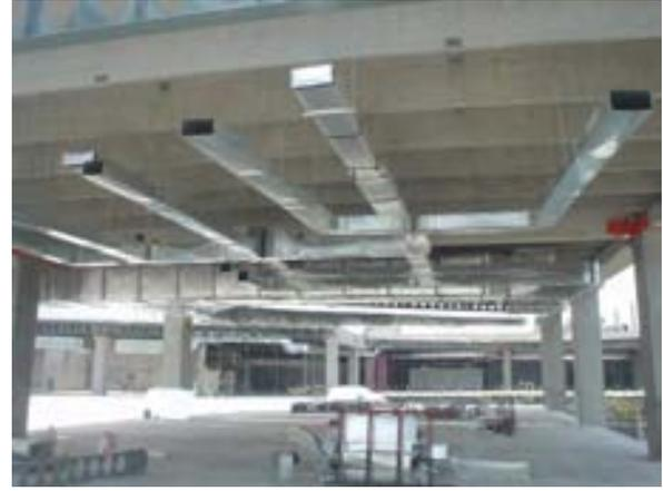
FIGURA 102. RAMALEO DE DUCTOS
