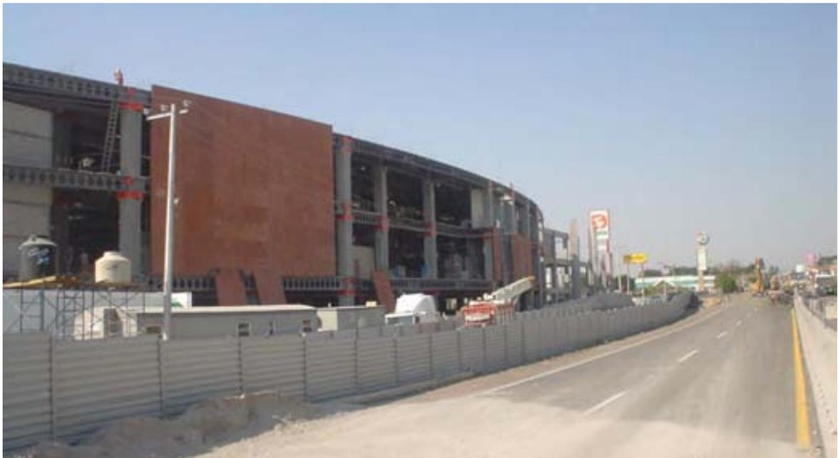
FIGURA 20. MONTAJE DE TABLEROS DE FACHADA
