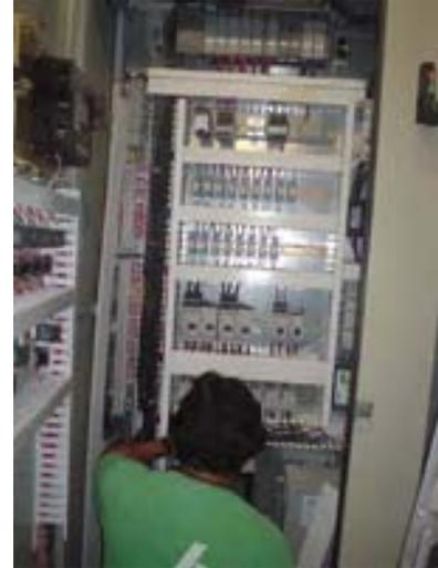
**Planta de emergencia.** Las pruebas efectuadas consistieron en simular la falta de energía eléctrica con el objeto de que, de manera automática, entre en funcionamiento la planta 5 segundos después. Asimismo se hacen mediciones de cantidad de corriente (amperes) y voltaje.
