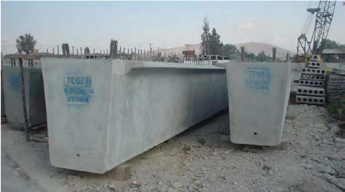
FIGURA 66. TRABES CAJÓN DEL PUENTE
