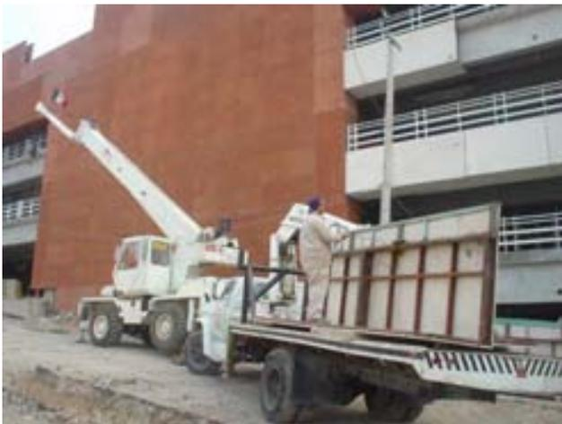
FIGURA 106. COLOCACIÓN FACHADA PREFABRICADA
