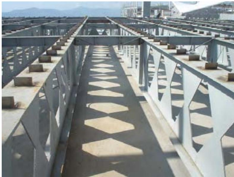
FIGURA 35. ESTRUCTURA DE LA LOSA PARA DESPLANTE DE CINES
