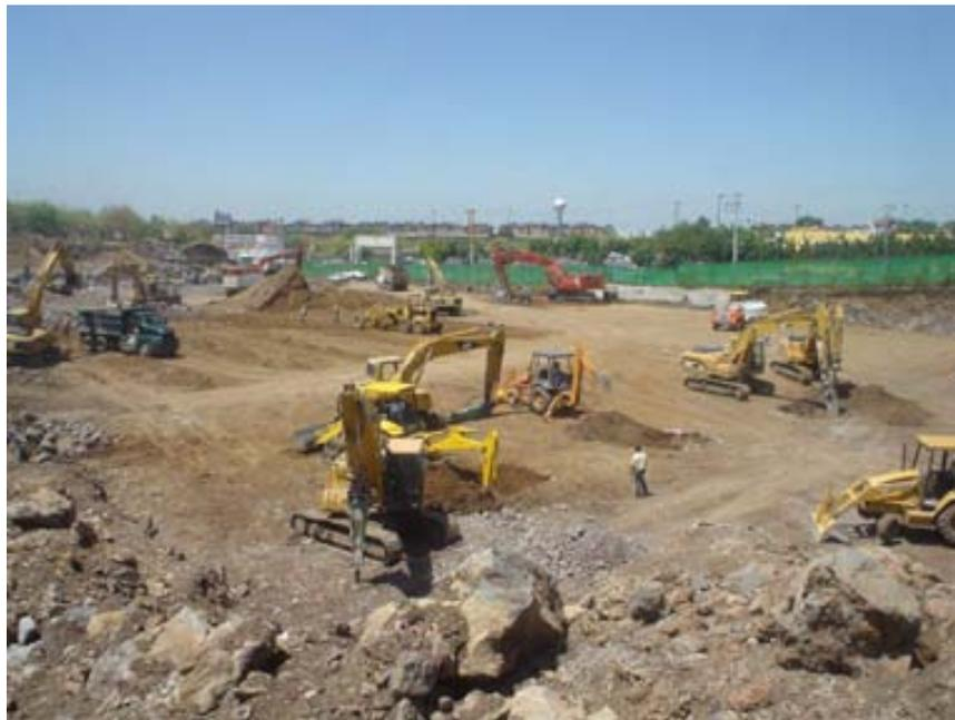
FIGURA 24. EXCAVACIÓN DE CEPAS DE ZAPATAS
