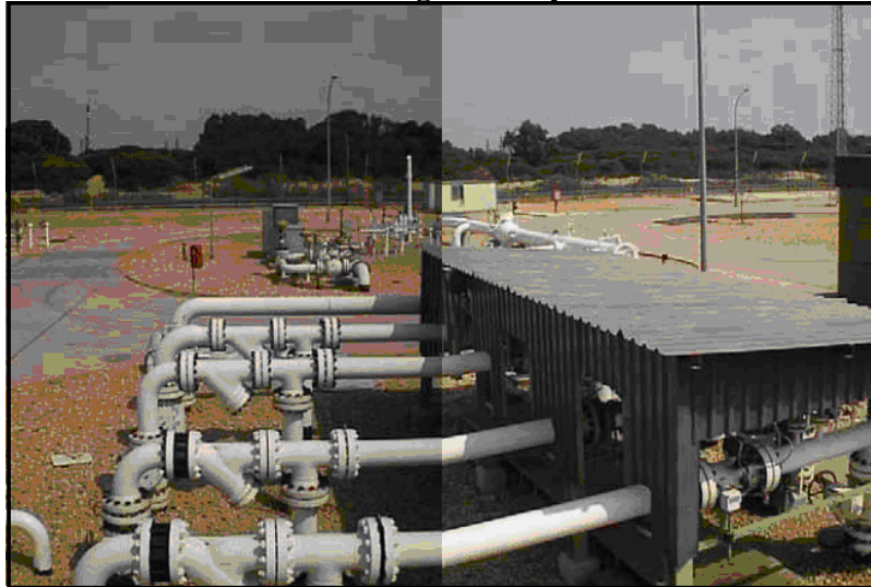
Figura 15 Estación de regulación y medida
