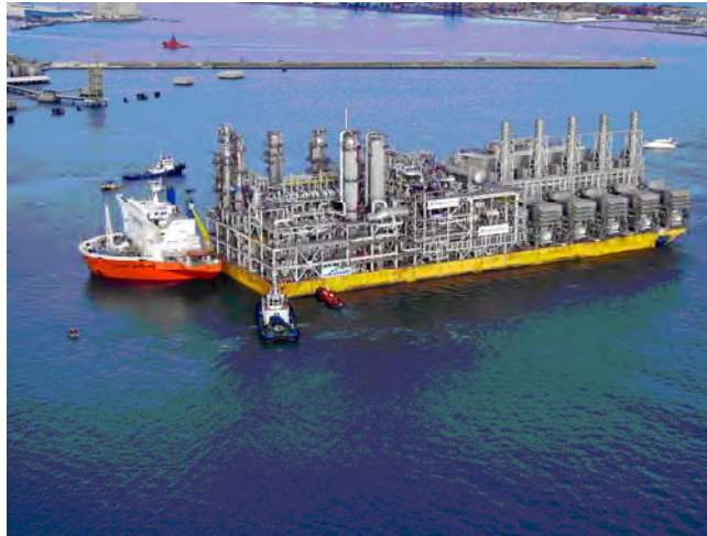
Figura 11 Planta de Licuefacción
