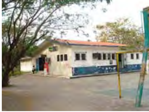
FIGURA 70. Oficinas de “TELECOM” y “Correos de México”.
